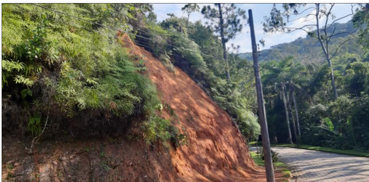
Figura 16 – Registro fotográfico de deslizamento observado na ADA, observa-se que devido à baixa cobertura do solo essas áreas ficam mais susceptíveis a esses eventos.
