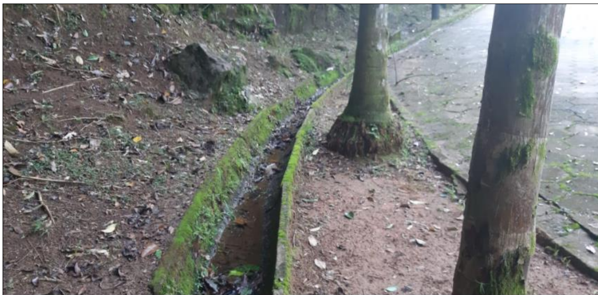
Figura 21 – Curso d'água que atravessa o loteamento, apresenta-se canalizado para melhor escoamento direcionado.
