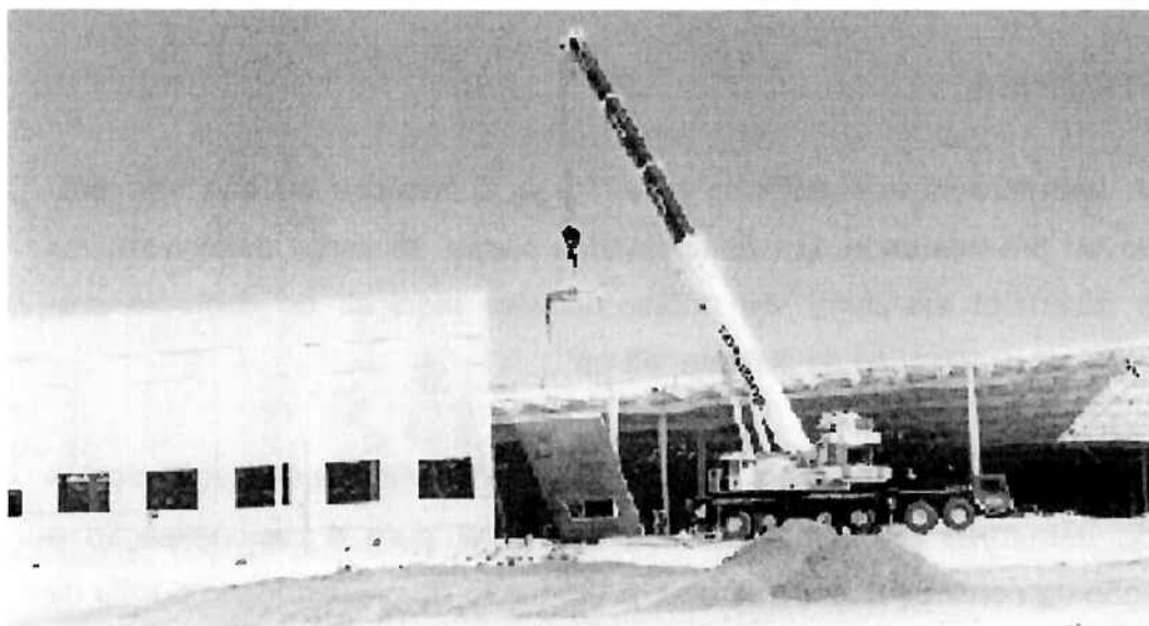
Figura 8 – Execução de painéis do sistema "tilt-up"
