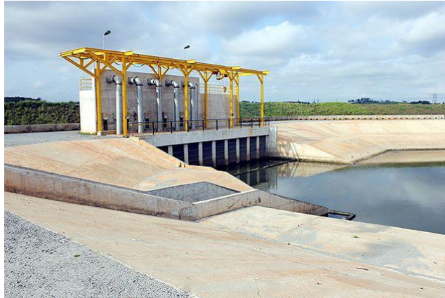
Figura 33 - Casa de bombas para esvaziamento do piscinão. Disponível em http://mural.blogfolha.uol.com.br/2012/12/06/apos-3-anos-jardim-romano-relembra-enchente-que-durou-meses .
