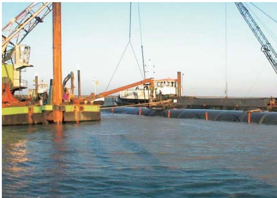
Figura 27 - Processo de enchimento do geotube. Fonte: Spelt (2001)
