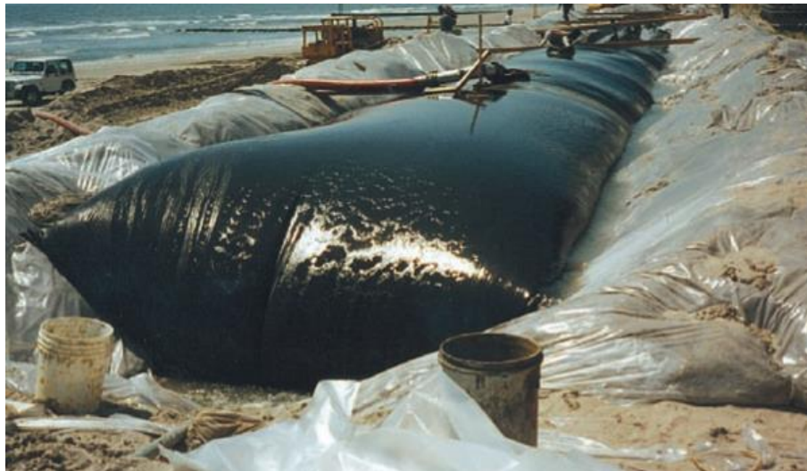
Figura 17 - Bolsões geotêxteis sendo aplicados para proteção da praia em Atlantic City, NJ – EUA. Fonte: Site da fabricante Tencate ( http://www.geotube.com , acesso em 20/06/13)
