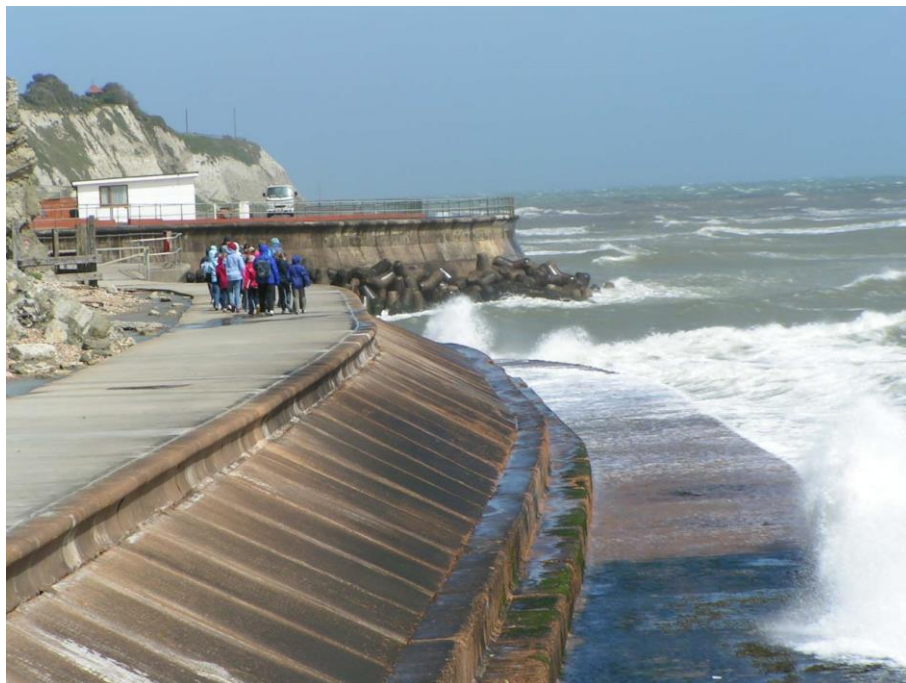
Figura 13 - Exemplo de técnica “rígida” de engenharia (um seawall) citada por Colenutt (2001). Fonte: Site ClimateTechWiki ( http://climatetechwiki.org/content/seawalls , acesso em 20/06/13)
