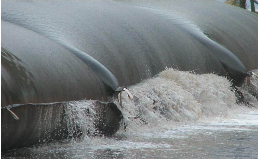
Figura 15 - Bolsão geotêxtil sendo utilizado para adensamento de solo (“dewatering”). Fonte: Site da fabricante Tencate ( http://www.geotube.com , acesso em 20/06/13)
