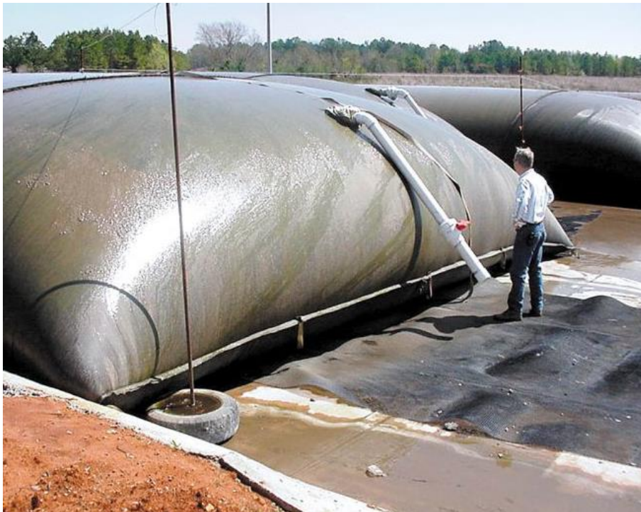
Figura 14 - Bolsões geotêxteis em sua fase final de enchimento. Fonte: Site Specialty Fabrics Review ( http://specialtyfabricsreview.com/articles/0909_sw2_geotubes.html , acesso em 20/06/13)
