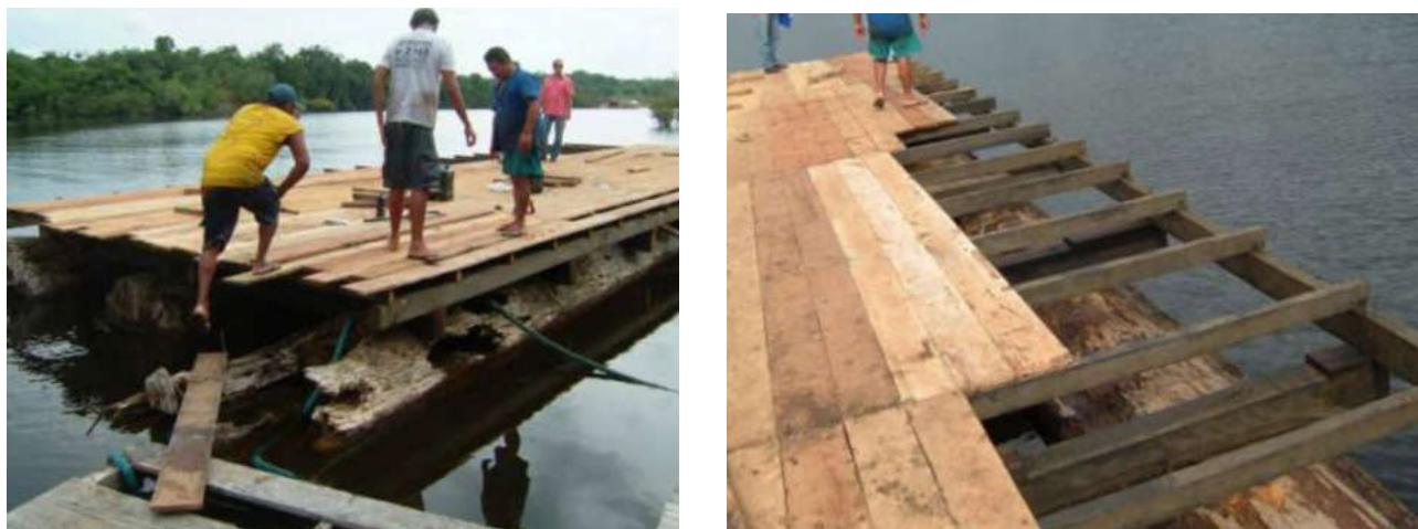
Montagem da base de uma habitação flutuante como sistema de flutuação a partir de tora de Açacu Imagem: Sergio Lima. Fonte: OLIVEIRA JUNIOR, Jair Antonio de. Arquitetura Ribeirinha sobre as águas da Amazônia: o habitat em ambientes complexos.
