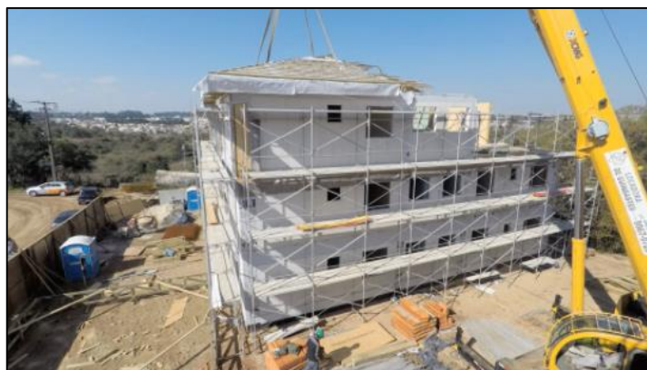
Figura 7 – Finalização da montagem do prédio em Wood frame em Araucária-PR. (Fonte: Tecverde, 2016)
