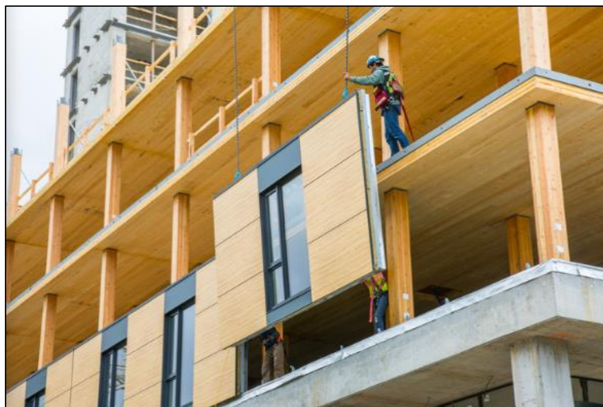
Figura 4 – Painéis de fechamento em CLT sendo posicionados na fachada do Brock Commons Tallwood . (Fonte: Archdaily, 2017)
