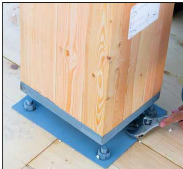
Figura 15 – Fixação da base do pilar na laje. (Fonte: naturally:wood, 2016)
