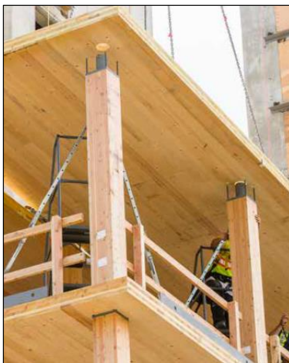
Figura 14 – Encaixe das lajes nos pilares por meio de pré-furações. (Fonte: naturally:wood, 2016)
