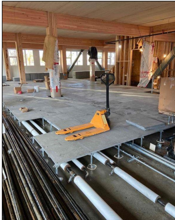
Figura 46 – Piso elevado do edifício Tallwood 1. (Fonte: District 56, 2021)
