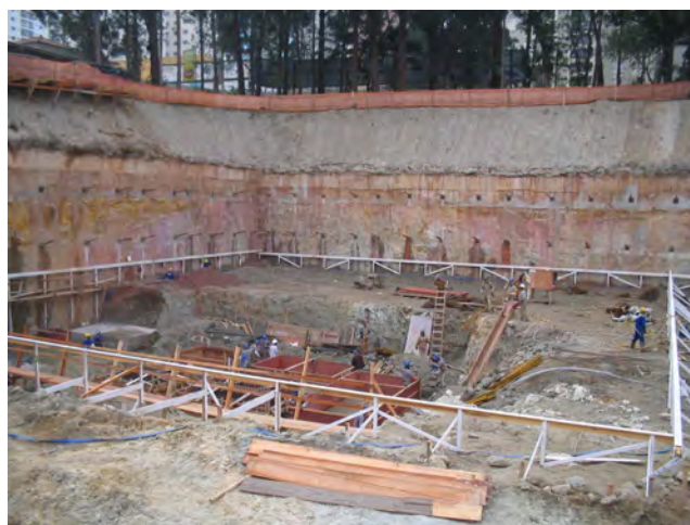
Figura 4.8 – Gabarito e fundação da Torre Mirante (junho/06).
