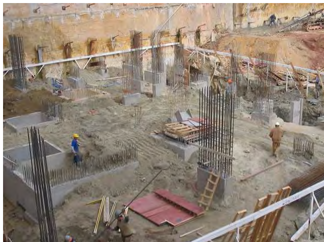
Figura 4.10 – Prolongamento dos pilares e reaterro da Torre Horizonte (agosto/2006).
