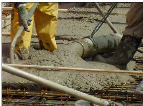
Figura 3.56 – Lançamento do concreto através da bomba com auxílio da mão-de-obra.
