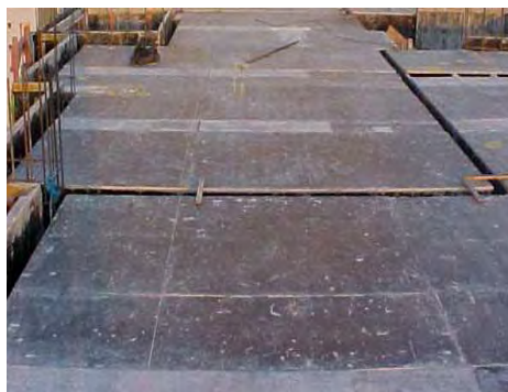
Figura 4.22 – Assoalho em madeira compensada plastificada.
