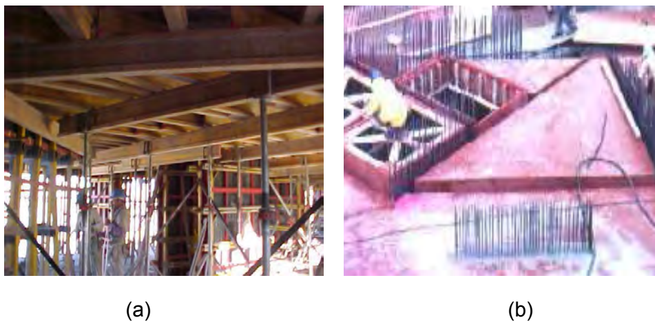
Figura 3.34 - Exemplo de flexibilidade do sistema tramado com a moldagem de laje em formato triangular: a) vista inferior do cimbramento da laje; b) vista superior do molde da laje – Fonte: FREIRE (2001).
