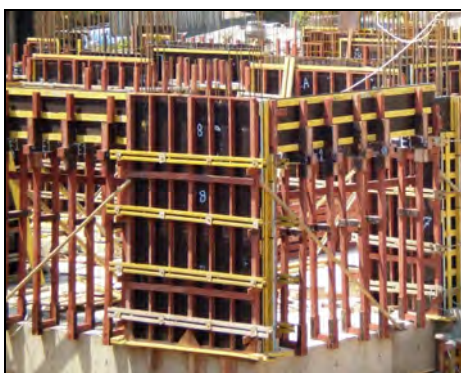
Figura 3.15 – Molde em madeira para fôrmas de vigas e pilares.
