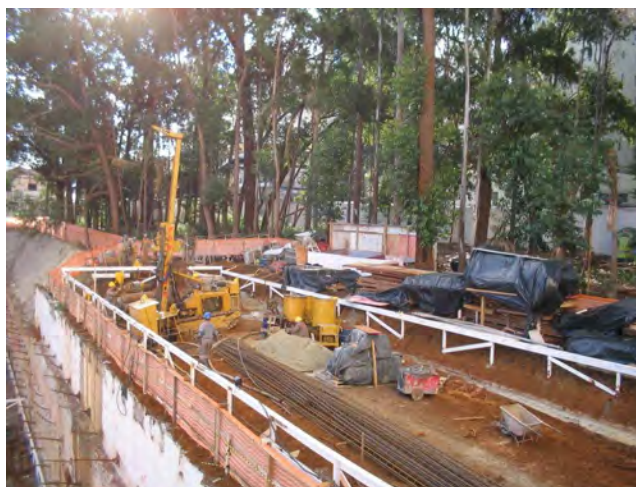
Figura 4.9 – Execução de estaca raiz na Torre Horizonte (julho/2006).
