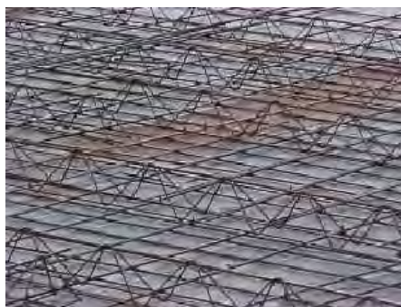
Figura 3.5 – Armação da laje apoiada pelo sobre o assoalho de madeira.
