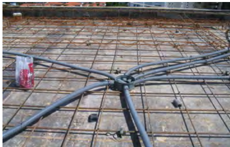
Figura 4.27 – Posicionamento embutidos: caixa de elétrica sobre a fôrma.
