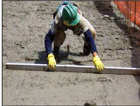
Figura 3.61 – Nivelamento do concreto com réguas de alumino.
