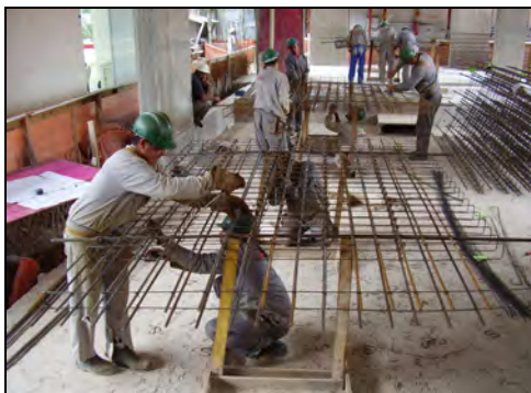
Figura 4.25 – Pré-montagem de um pilar na central de armação do térreo.
