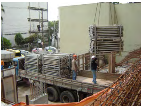
Figura 4.37 – Transporte de cimbramento utilizando a grua.
