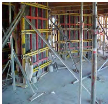
Figura 3.30 - Fôrmas de pilar com grade de madeira, vigas de travamento metálicas, barras de ancoragem e mãos-francesas em cantoneiras metálicas.
