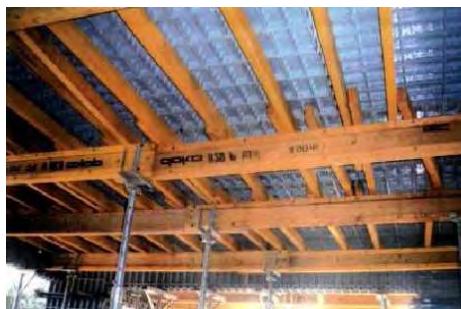
Figura 3.12 – Molde de laje com fôrma em painel sintético.
