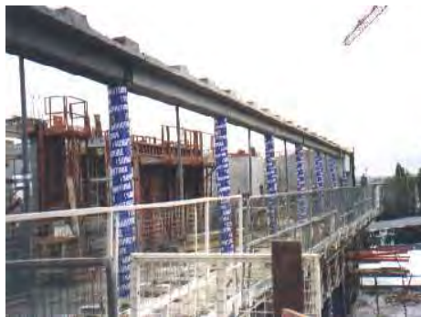
Figura 3.18 – Molde em papelão para fôrma de pilares.
