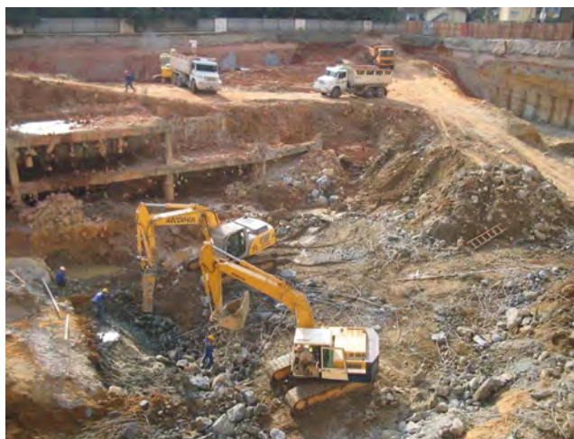
Figura 4.6 – Escavação e demolição (abril/2006).
