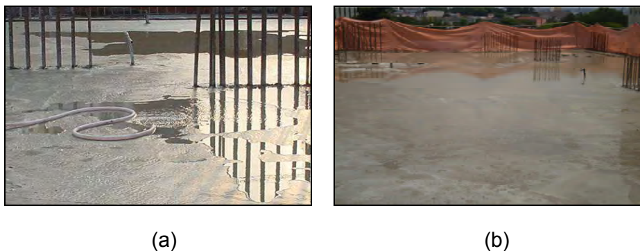
Figura 3.62 – Cura da laje utilizando o represamento de água.
