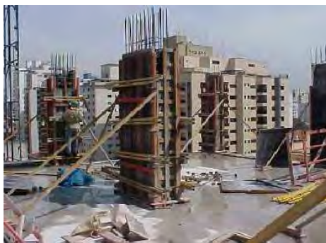
Figura 3.8 – Estrutura de uma laje recém concretada.
