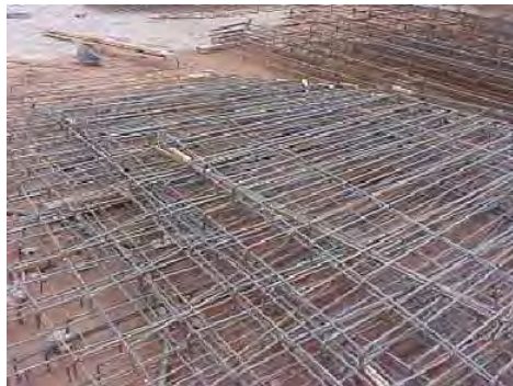
Figura 3.48 – Pré-montagem da armação de uma laje.
