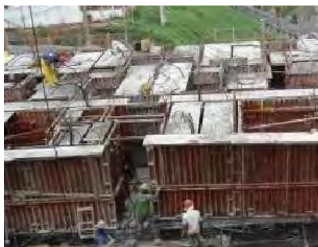
Figura 3.19 – Molde metálico para fôrmas de paredes.
