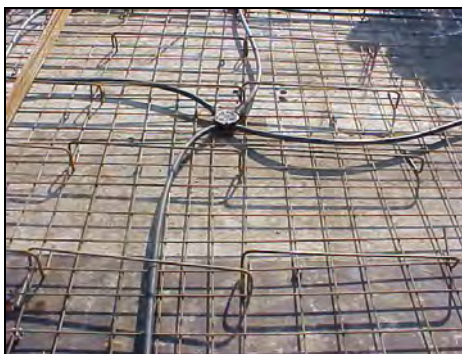
Figura 3.52 – Posicionamento da caixa de elétrica sobre a fôrma.
