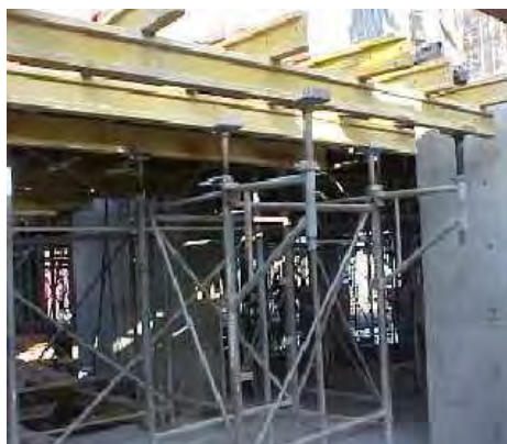
Figura 3.22 – Escoramento com torres metálicas e vigas de madeira.
