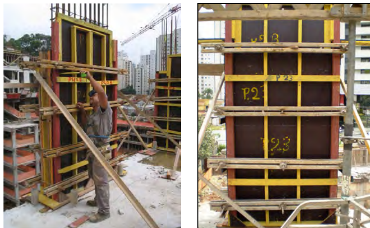
Figura 4.17 – Fôrma para molde dos pilares.
