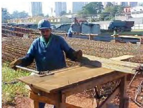
Figura 3.44 – Dobramento manual do aço no canteiro com a utilização da bancada.
