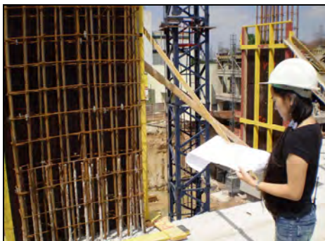
Figura 3.50 – Conferência da montagem da armadura de um pilar.
