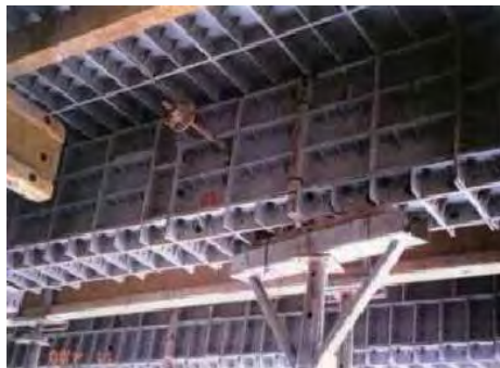
Figura 3.17 – Molde sintético para fôrma de vigas e lajes.
