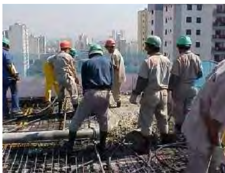
Figura 3.7 – Atividades de armação e concretagem executadas sobre o sistema de fôrmas.
