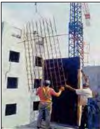
Figura 3.47 – Posicionamento da armadura do pilar com a utilização da grua.
