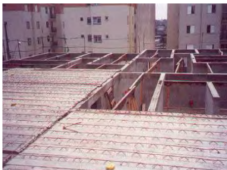
Figura 3.14 – Molde em pré-laje.
