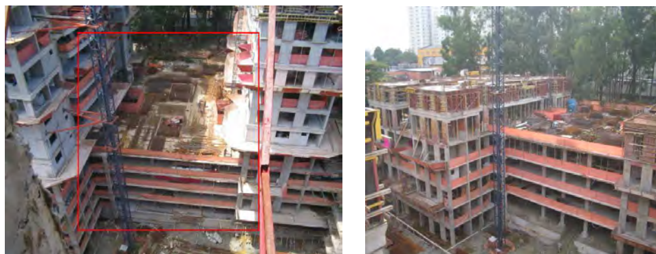
Figura 4.31 – Estrutura da periferia no trecho 1, para ligação das torres 2 e 3.
