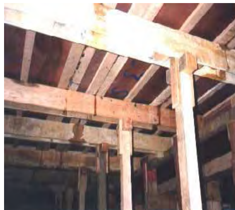
Figura 3.32 - Sistema tramado com molde em chapa de compensado, vigamentos superior e inferior constituído de sarrafos e vigas sanduíche de madeira e escoramento com pontaletes com cruzetas – Fonte: FREIRE (2001).
