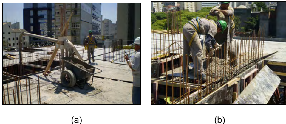
Figura 3.55 – Transporte do concreto até o local de aplicação: a) uso de bomba estacionária até o pavimento; b) uso de jerica para transporte do concreto até a peça a ser concretada.
