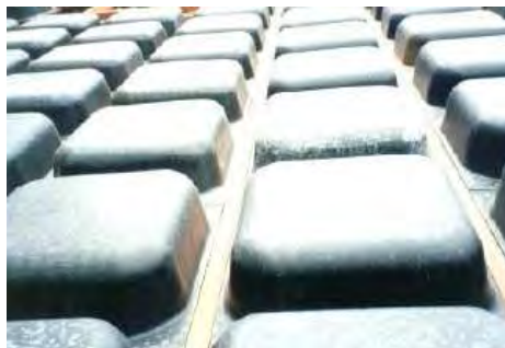
Figura 3.11 – Molde de laje nervurada com fôrma em plástico reforçado.
