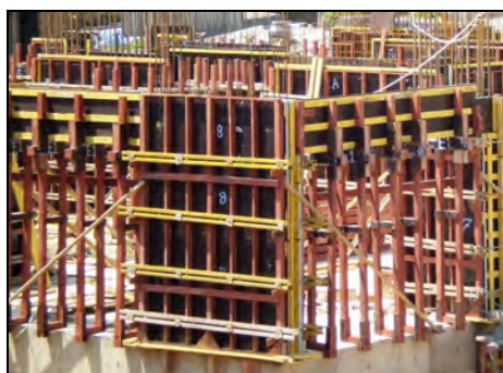
Figura 4.19 – Fôrmas e garfos de madeira para escoramento das vigas.
