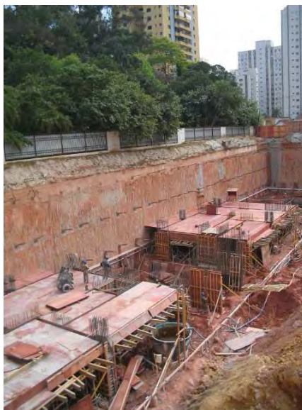
Figura 4.11 – Montagem da fôrma do piso do 4º subsolo da Torre Panorama (agosto/06).
