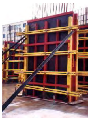
Figura 3.30 - Fôrmas de pilar com grade de madeira, vigas de travamento metálicas, barras de ancoragem e mãos-francesas em cantoneiras metálicas.
