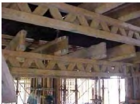
Figura 3.13 – Molde de laje com estruturação em madeira.
