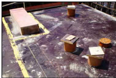
Figura 3.51 – Passagens no concreto em caixas de chapa de madeira compensada e tubos de PVC; e marcação das paredes com tinta.
