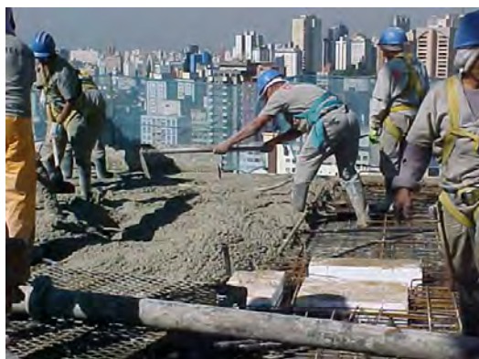
Figura 3.58 – Espalhamento do concreto com o auxílio de enxadas.
