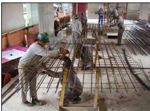
Figura 3.46 – Pré-montagem de um pilar na central de armação.
