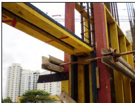
Figura 4.18 – Fôrma para molde das vigas e encontro com pilar.
