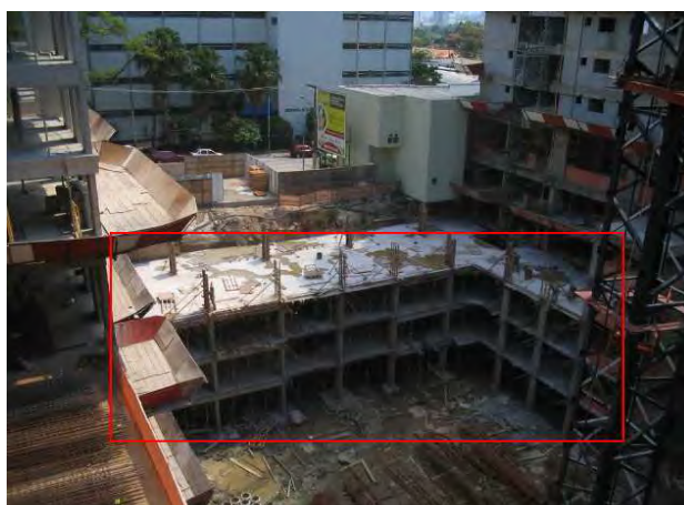
Figura 4.33 – Estrutura da periferia no trecho 3, para ligação da Rua Pensilvânia com as torres 1 e 2.
