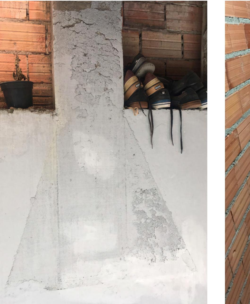
Escada - No muro de divisa está evidente uma coluna que se apoia diretamente nos blocos de concreto com uma base triangular. Esta coluna está sob uma quina do pavimento superior. A escada de concreto possui pisadas regulares, porém com espelho alto de 21cm de altura. (do autor)
