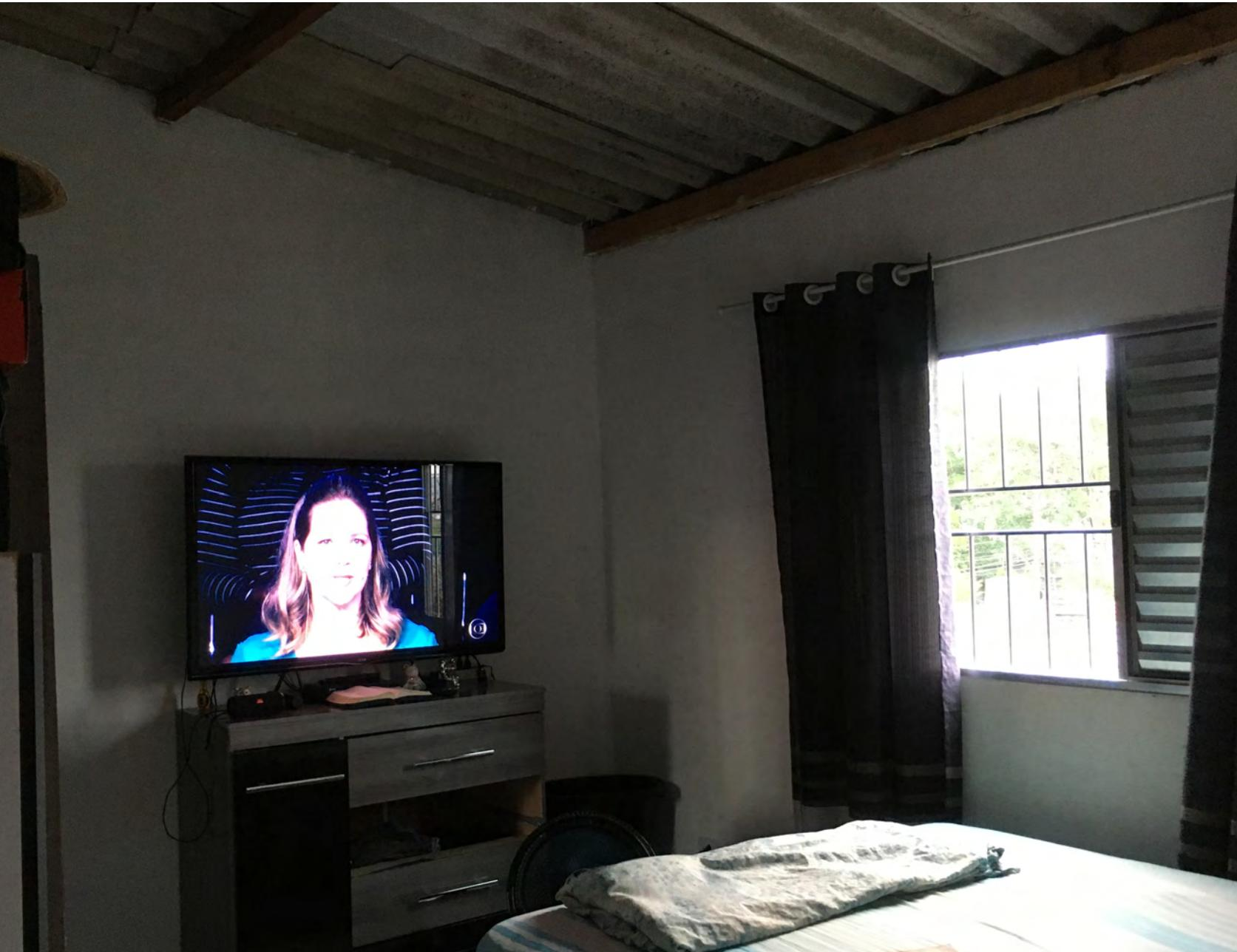
Quarto de Casal - As janelas dão para a rua, o que permite boas condições de iluminação natural. A cobertura é de telha e fibrocimento sem isolamento. (do autor)
