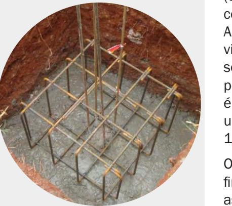
Imagen que destaca a “gaiola” da sapata corrida no momento de concretagem (fonte: totalconstrucao.com.br)
