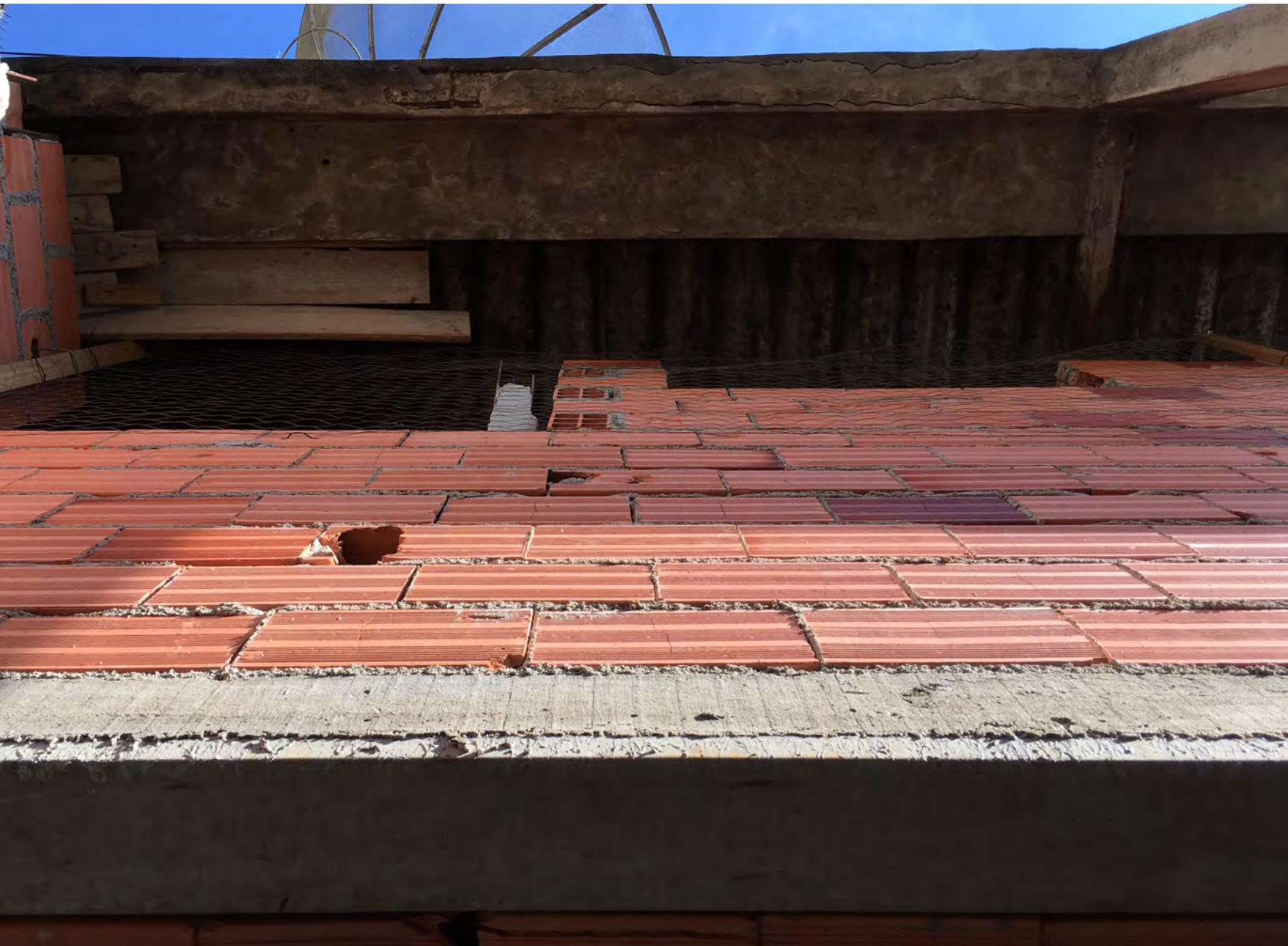
Corredor - uma calha de concreto armado foi construída a apenas 2,30m do piso do pavimento superior. (do autor)
