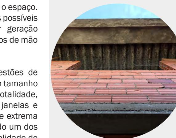
Existe uma calha de concreto arrancado do edifício em cima no primeiro pavimento. (da autora)
