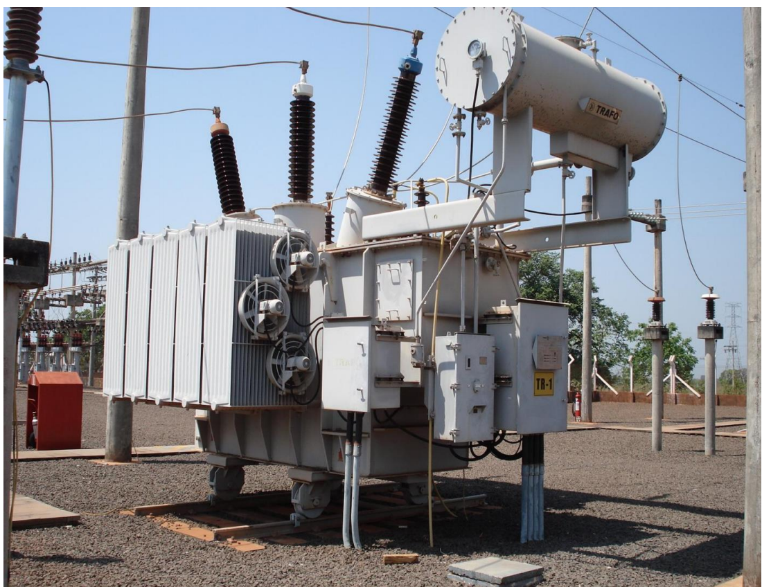
Figura 3 - Transformador de potência em subestação da Elektro [5]
