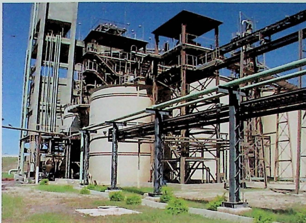
Foto 1 – Usina de recebimento do concentrado de apatita de Tapira
