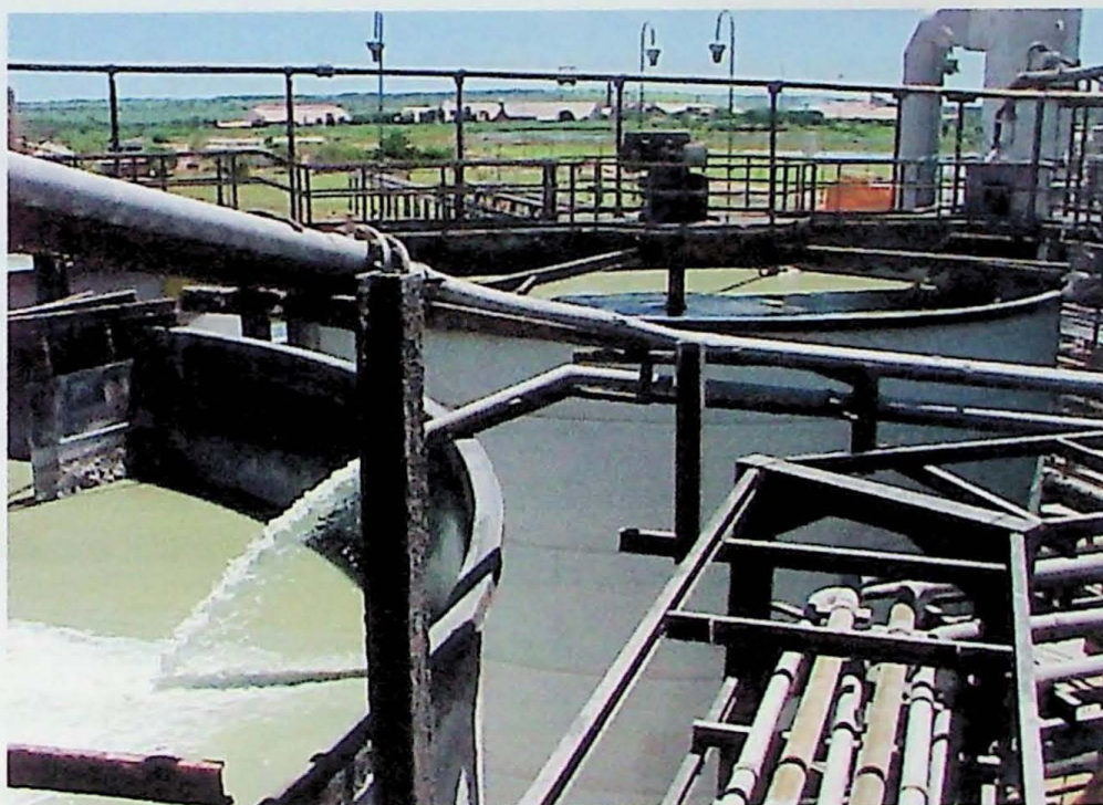
Foto 4 – Tanques de estocagem de ácido fosfórico
