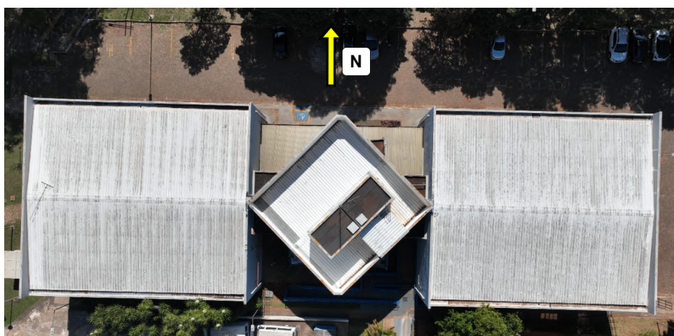
Figura 25 – Fotografia atualizada do Bloco D.
