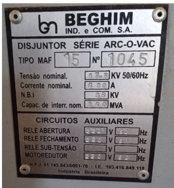
Disjuntor do lado de Alta Tensão da Subestação Principal
