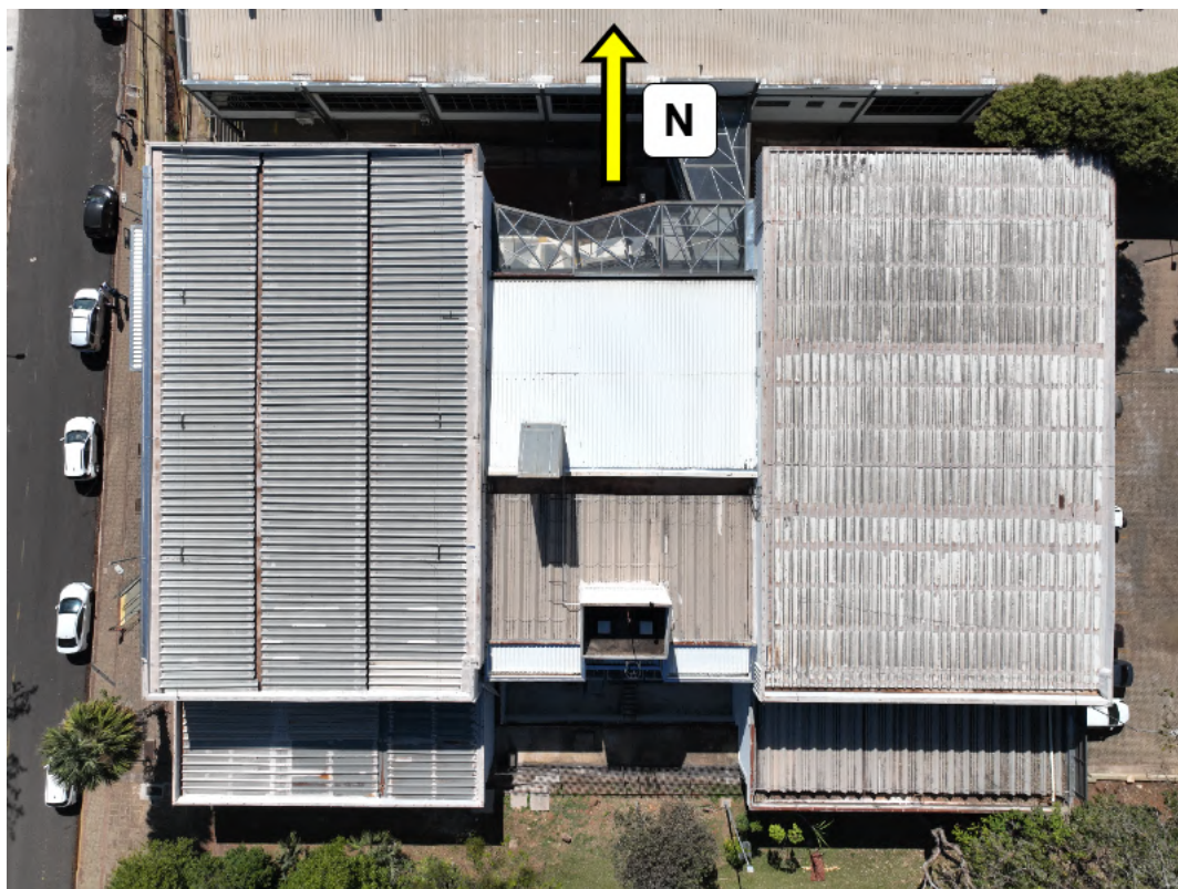
Figura 19: (EESC-Bib) Vista de cima do lugar da instalação.
