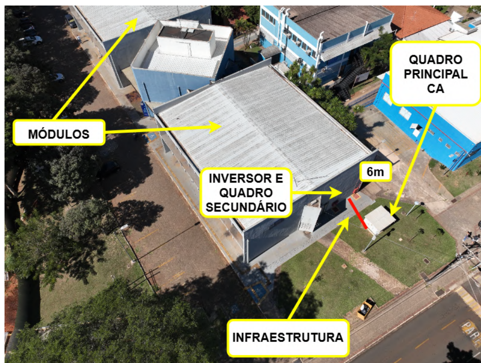
Figura 27 – Infraestrutura necessária para o Bloco D.
