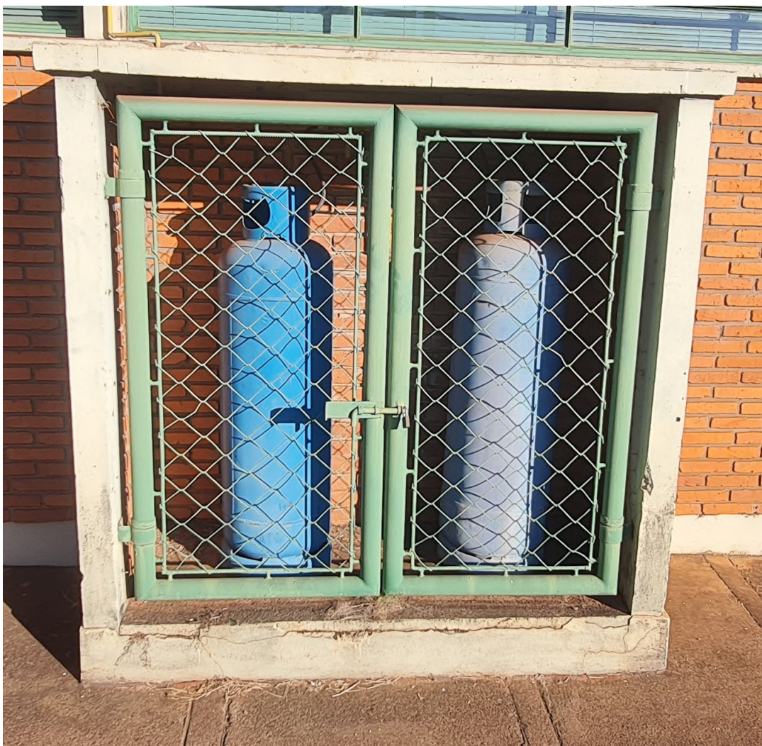
Figura 18: Estrutura de alvenaria.
