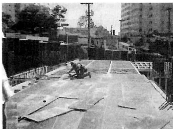
Figura nº 61 - Assoalhamento da laje 01
