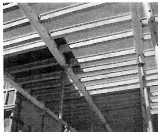
Figura nº 62 - Assoalhamento da laje 02
