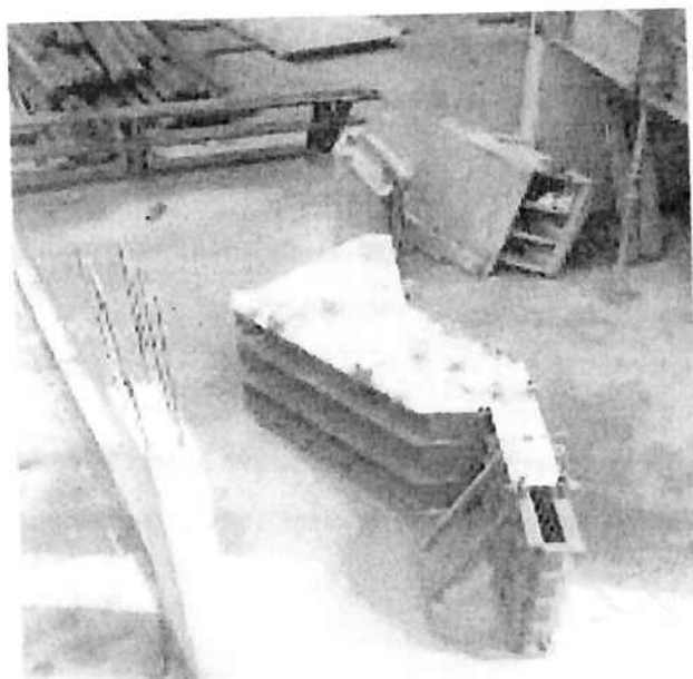
Figura nº 33 – Escada pré-moldada ainda com o molde
