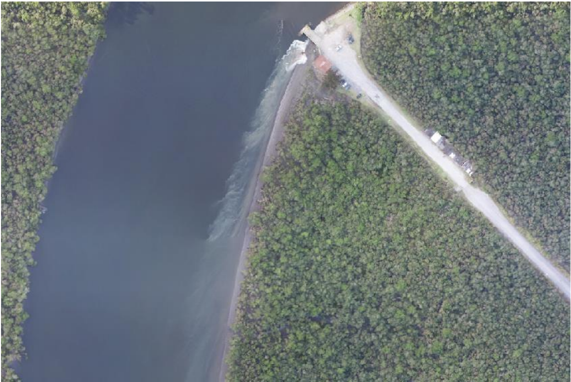
Figura 21 - Ortomosaico em detalhe - lançamento de esgoto no canal de Bertioga
