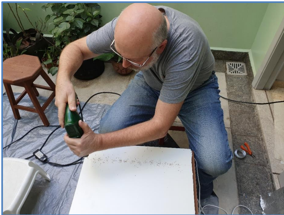
Imagem 18 – Furação para instalação do arame
