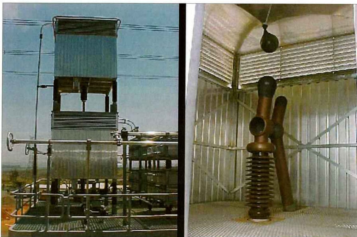
Figura 7 – Foto da gaiola protetora do spark gap a direita e dos terminais do spark gap
