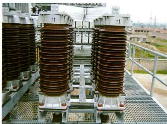
Figura 9 - Fotos de colunas de MOV de dois fabricantes diferentes
