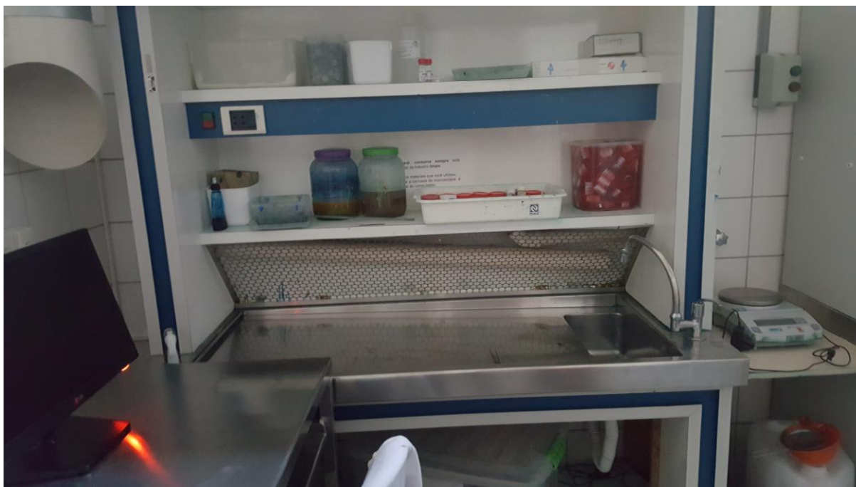
Figura 14 tubo de exaustão a 1,5 metros do solo e recipiente para coleta de formol no nível do chão
