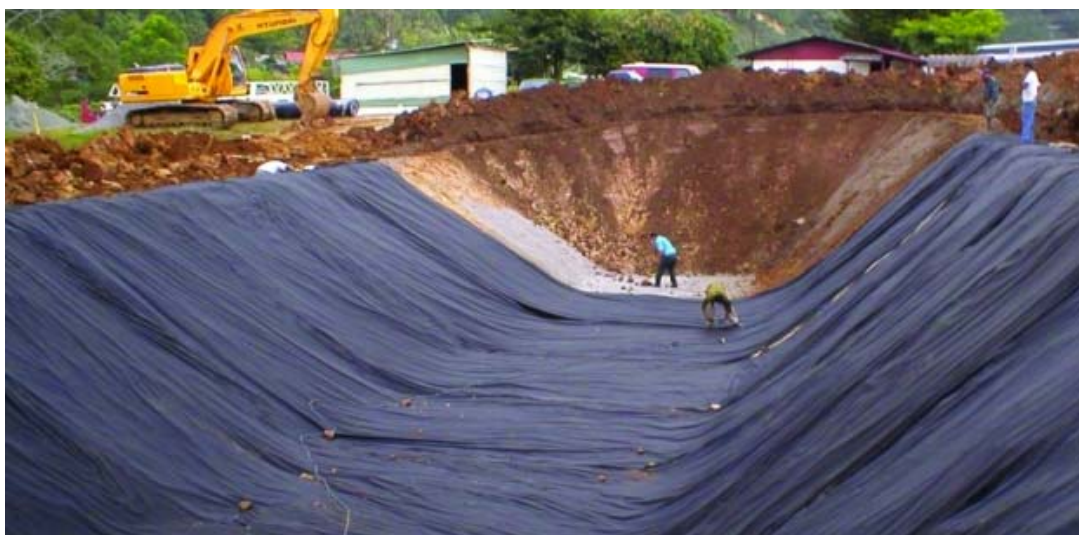
Figura 12.9 - Manta geotêxtil não tecido 100% polipropileno 46
