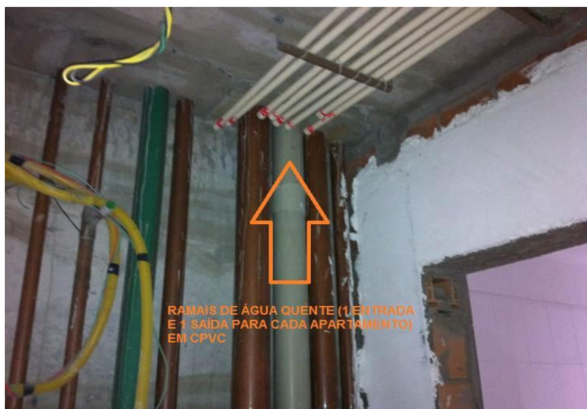
Figura 29: Tubulações de entrada e saída de água quente de cada um dos quatro apartamentos em CPVC a serem conectadas a prumada correspondente.
