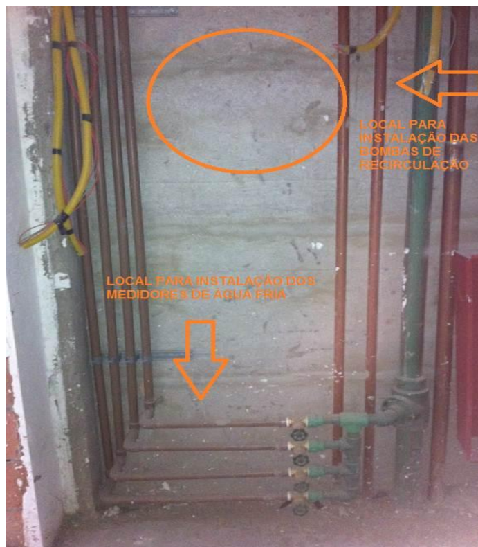
Figura 28: Local para futura instalação dos medidores de água fria e bombas de recirculação ( shaft do andar).
