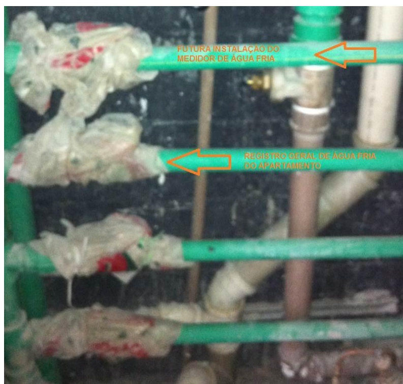
Figura 24: Registros dos quatro apartamentos do pavimento e local para futura instalação dos medidores de água fria, no shaft do andar.
