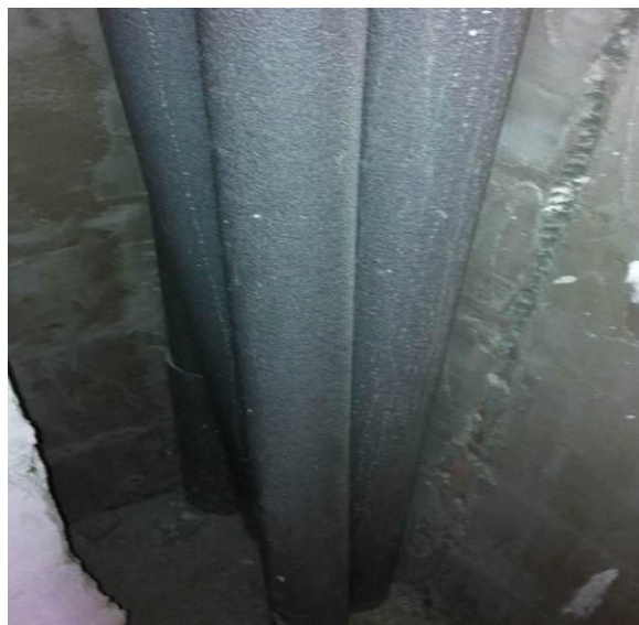
Figura 17: Colunas de distribuição de água quente, dentro do shaft .
