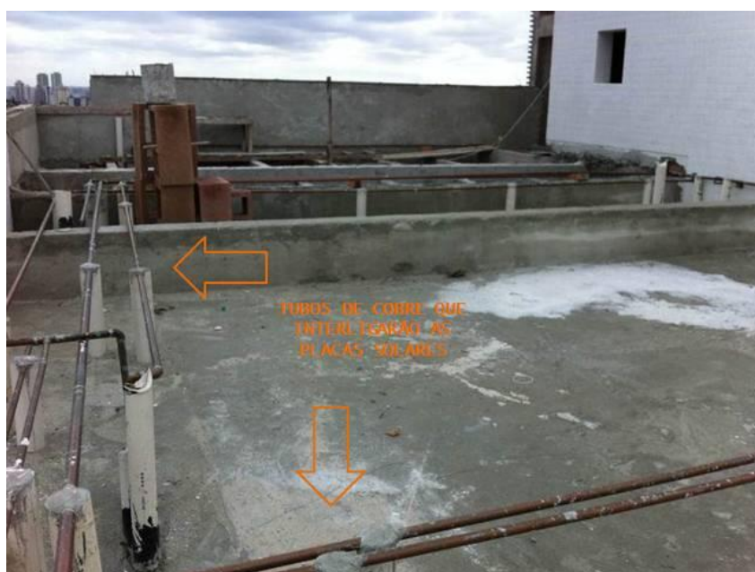
Figura 15: Tubulações em cobre que estarão ligadas as placas solares.
