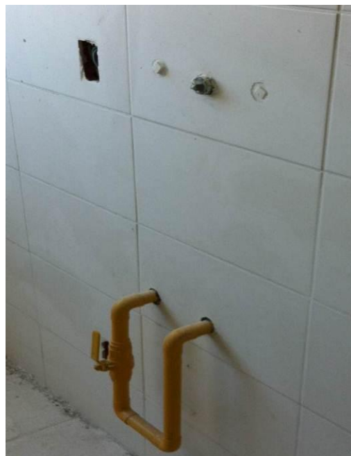
Figura 25: Local para futura instalação de aquecedor de passagem a gás.
