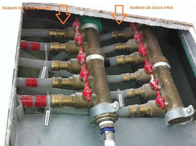
Figura 23: Entrada de água quente e fria do apartamento e seus ramais para os pontos de consumo.
