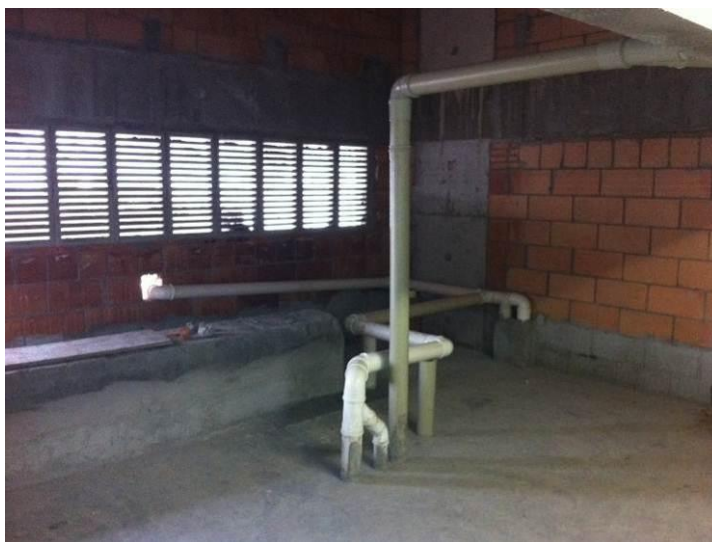
Figura 27: Local para colocação dos reservatórios de água quente.
