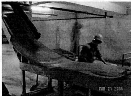
Figura 4.4 - Descarregamento do cimento com uso de escorregador – andar inferior
