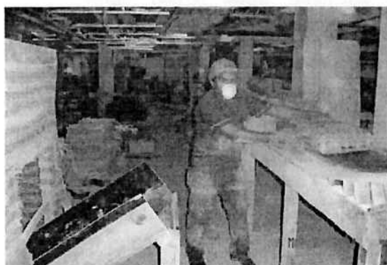
Figura 4.3 - Descarregamento do cimento com uso de escorregador – andar superior
