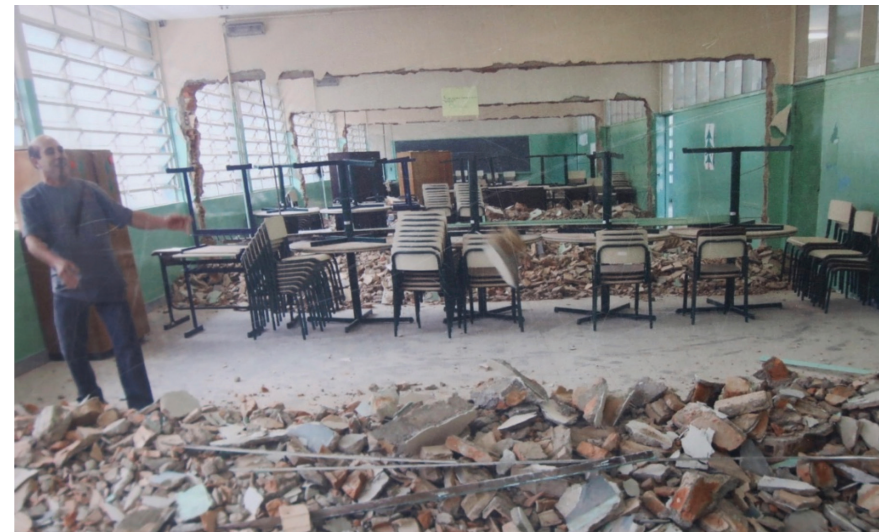
Processo de reforma na EMEF Campos Salles que fundamentou-se, principalmente, na derrubada das paredes entre as salas de aula para a conformação dos espaços de trabalho. Na foto, o diretor Braz Nogueira. Fonte: Transbordas.
