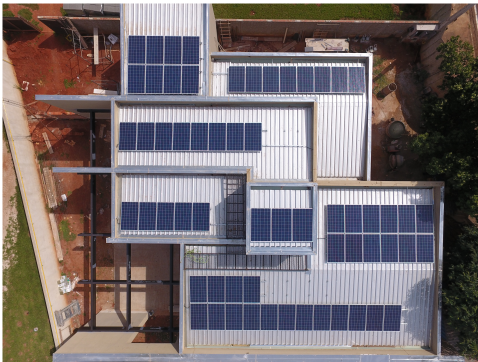
Figura 3: Sistema solar fotovoltaico 15,6 kWp instalado em São José do Rio Preto. O sistema conta com 60 módulos de 260 W.
