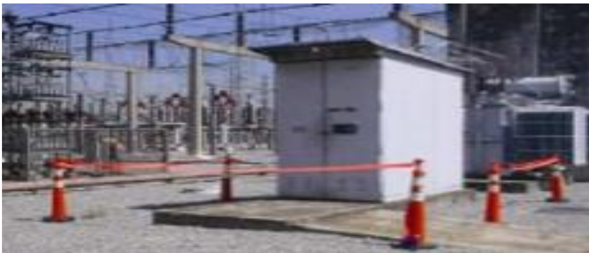
Figura 14: Isolamento das partes vivas
