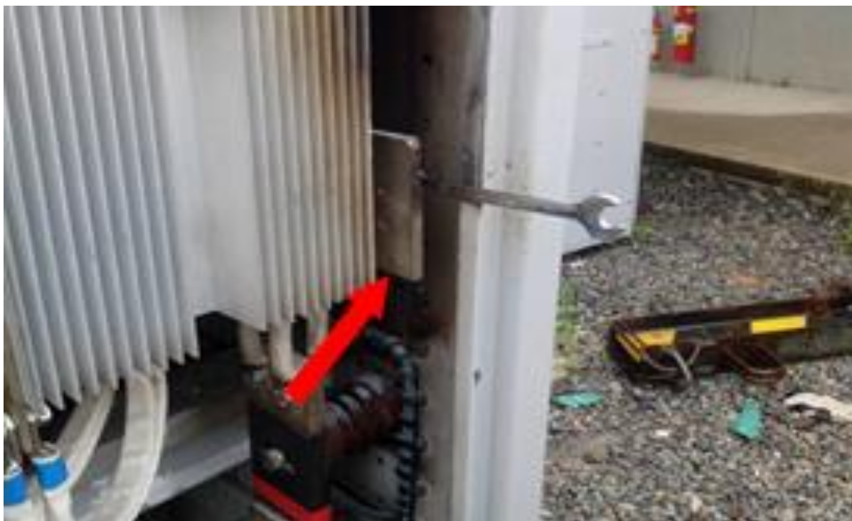
Figura 26: Lado traseiro da ponte retificadora onde o colaborador se aproximou com a ferramenta (chave de boca) para retirada de parafuso do barramento
