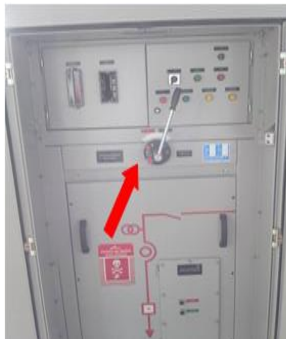
Figura 23 - A e B: Chave seccionadora - Cabine primária e Chave seccionadora - saída
