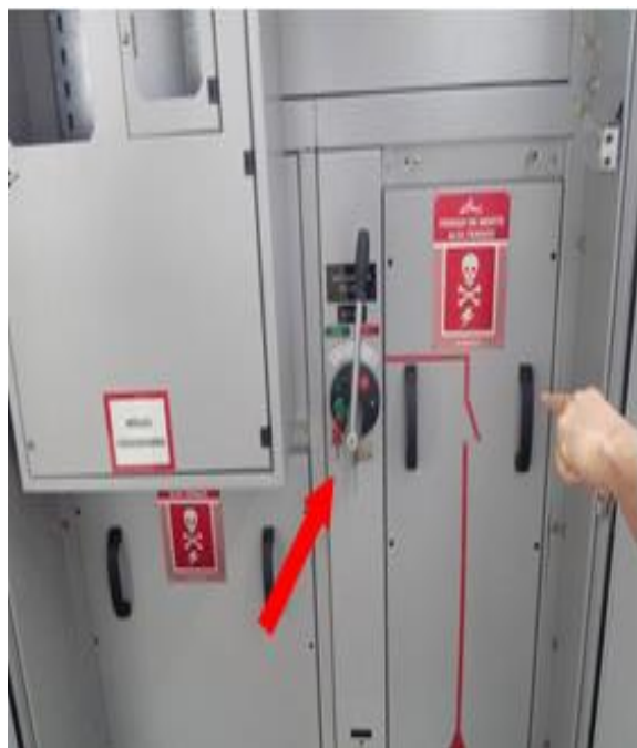
Figura 23 - A e B: Chave seccionadora - Cabine primária e Chave seccionadora - saída
