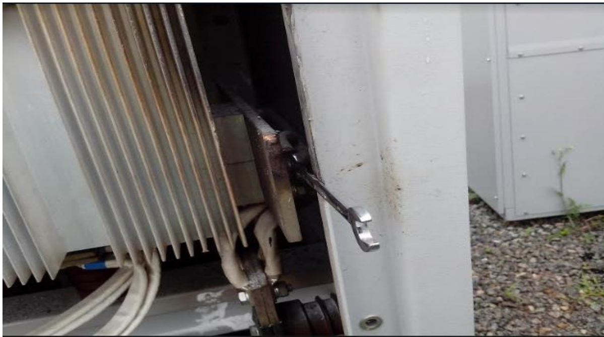
Figura 22: Parafuso do barramento da Estação Retificadora ER30
