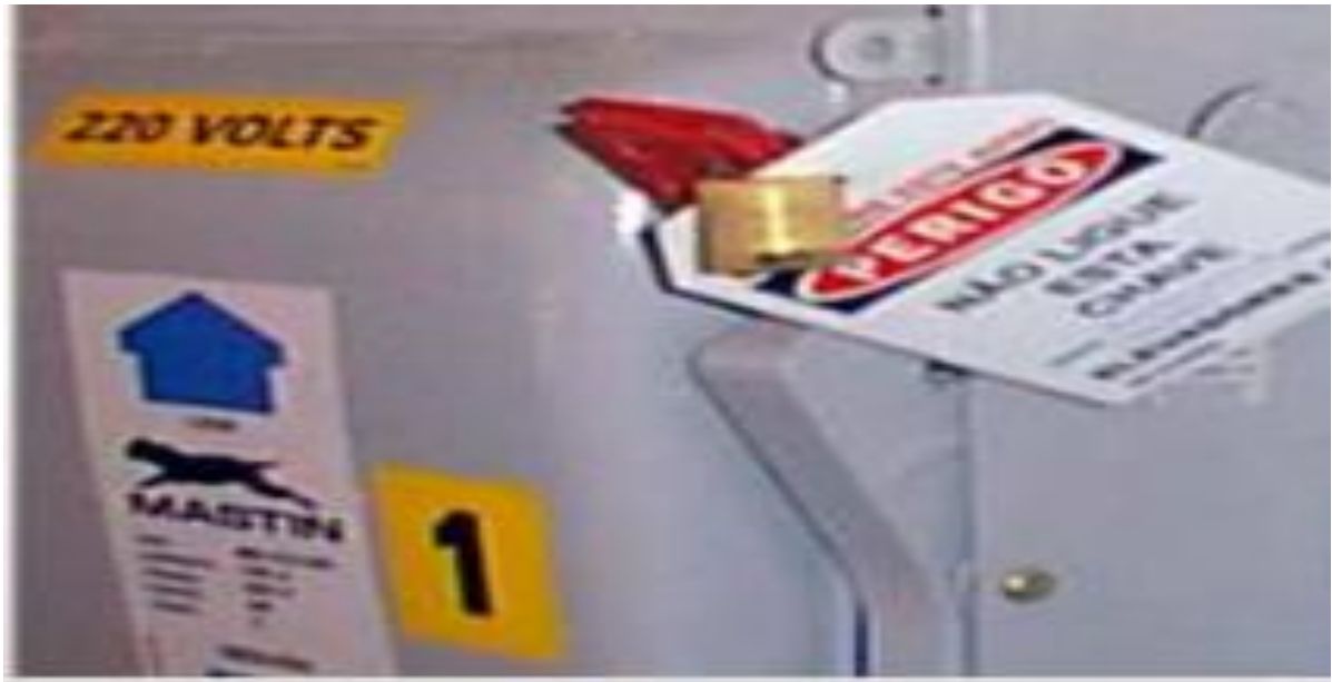
Figura 4: Instalação da sinalização de impedimento de reenergização
