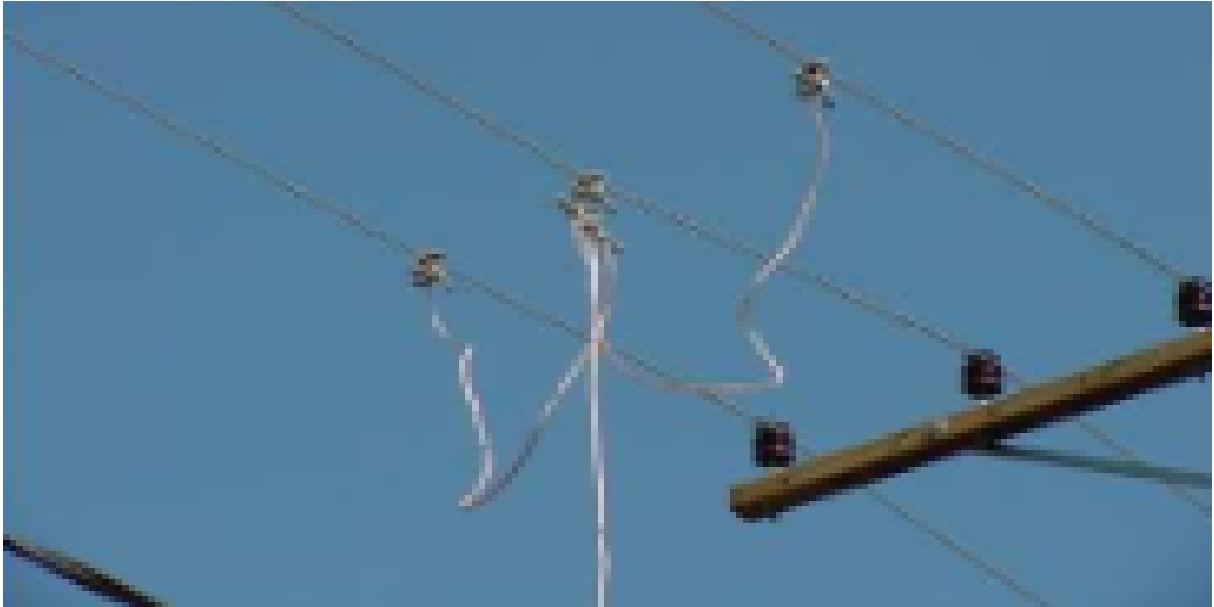
Figura 3: Instalação de aterro temporário com equipotencialização dos condutores dos circuitos
