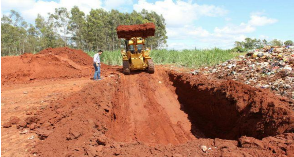
Figura 6: Abertura de una zanja
