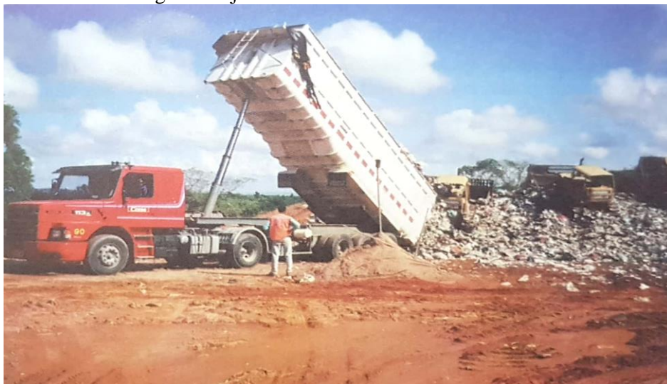
Figura 4: Ejecución del relleno sanitario en área
