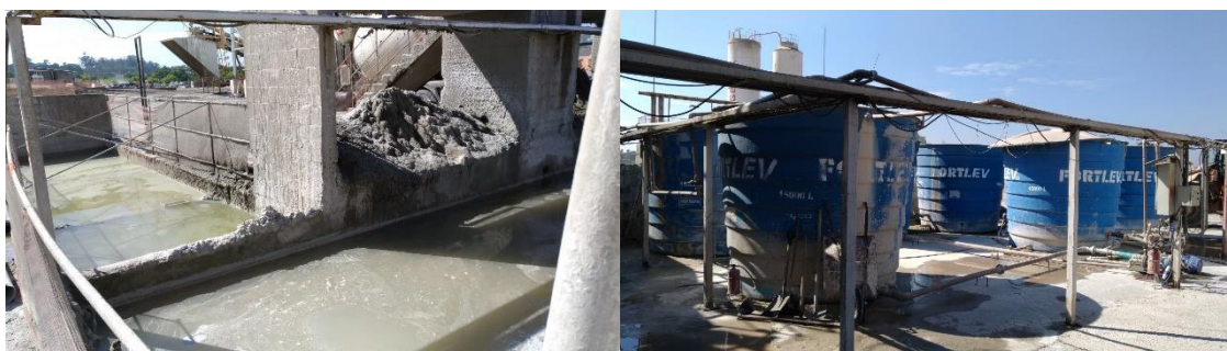
Figura 24 - Tanque de decantação & Caixas d'água
