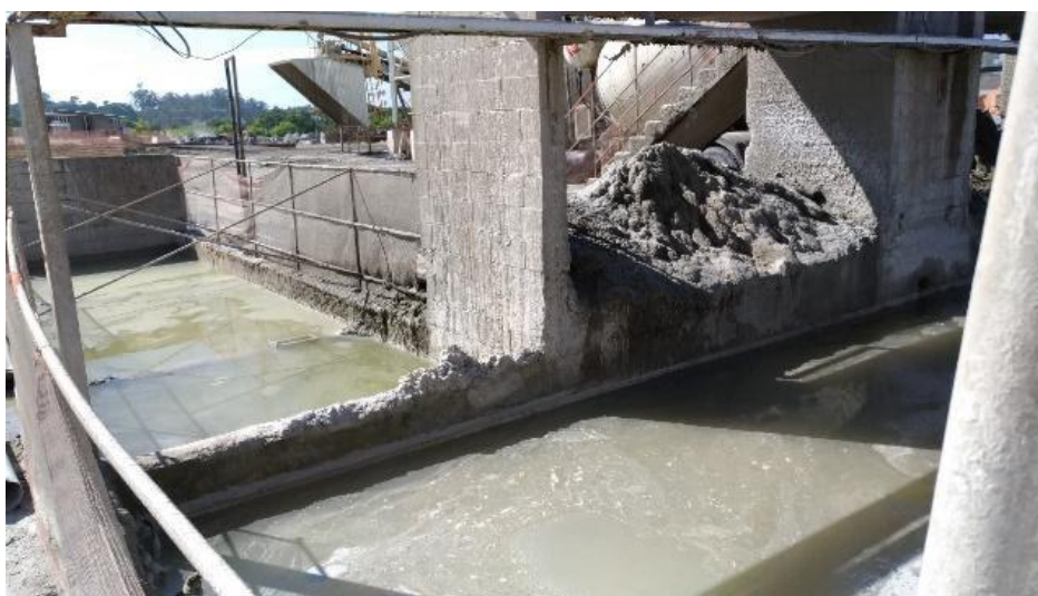
Figura 34 - Tanques de Decantação do Canteiro do Lote 5
