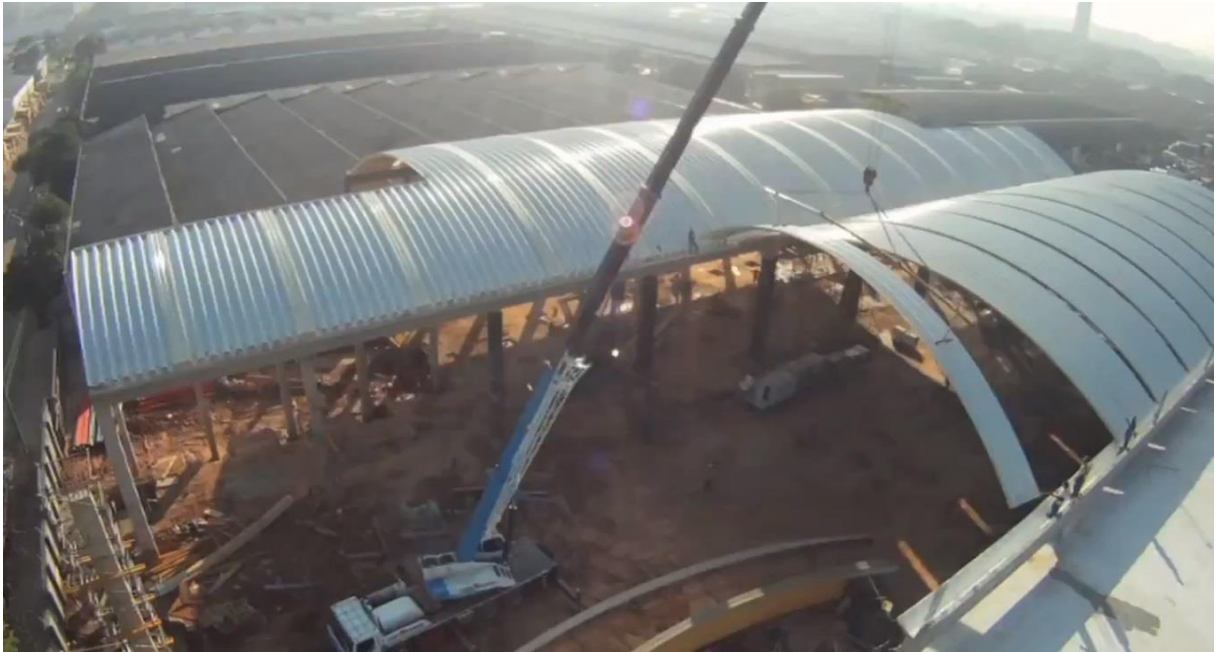
Figura 29: Execução da cobertura com telhas autoportantes (FONTE: Arcotop);
