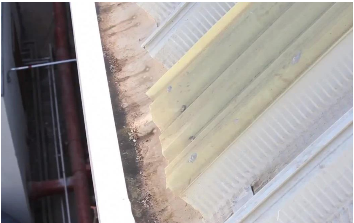
Figura 30: Ligação entre cobertura e estrutura, (FONTE: Arcotop);
