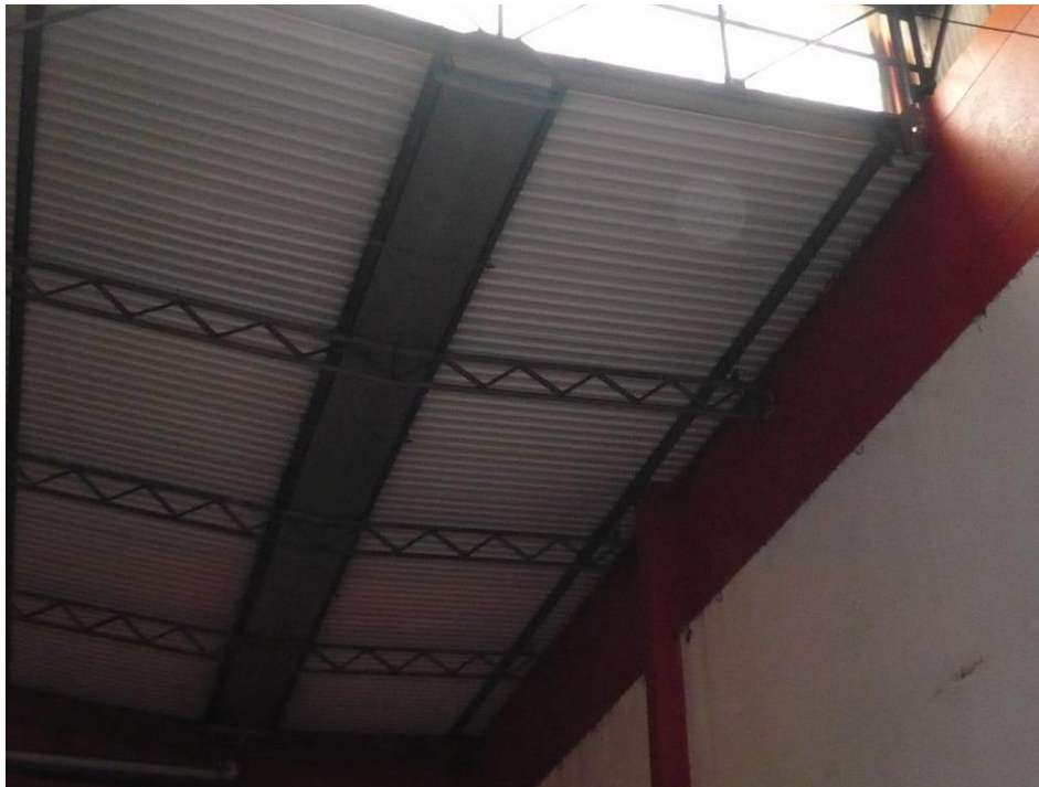
Figura 43: Foco na treliça metálica, (FONTE: Autoria do próprio grupo);
