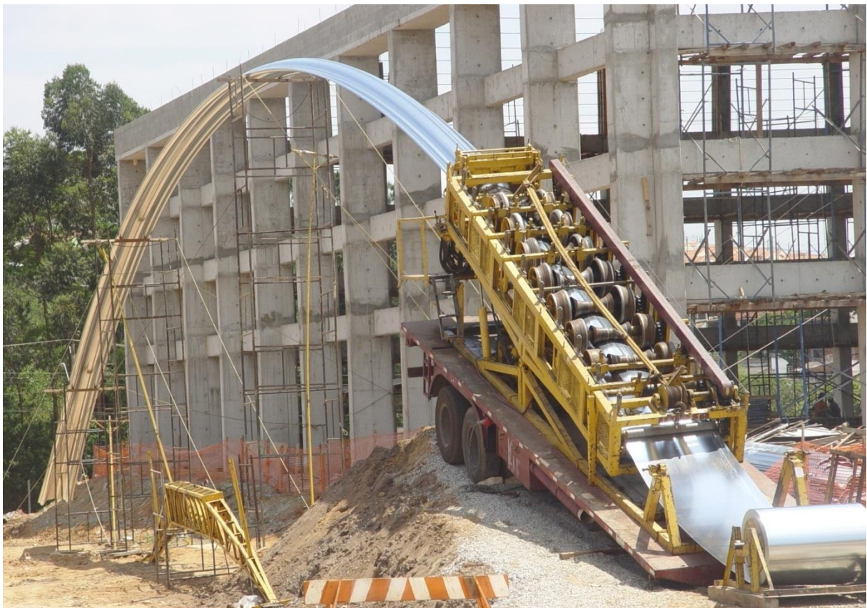
Figura 28: Execução das telhas autoportantes, (Fonte MANUAL AÇOPORT)
