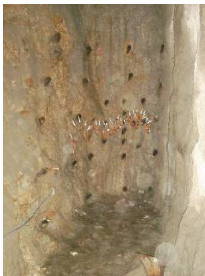
Figura 14 – Carregamento e detonação
