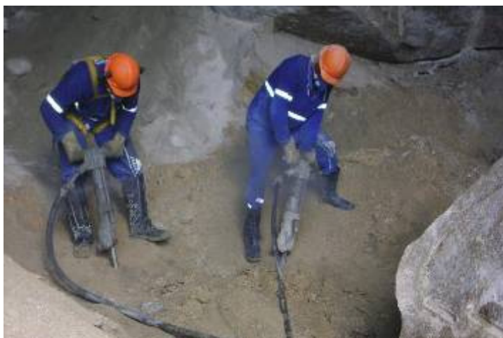
Figura 18 – Perfuração em rocha com martelo pneumático
