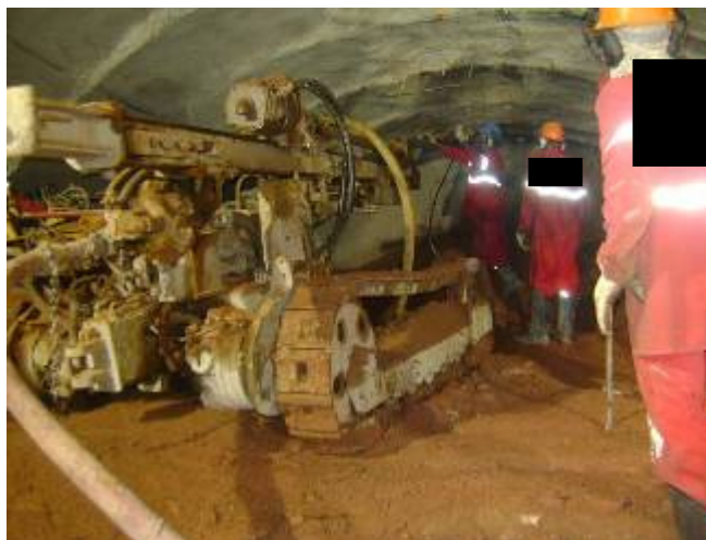
Figura 20 – Operação Jumbo/Perfuratriz (escavação em rocha)
