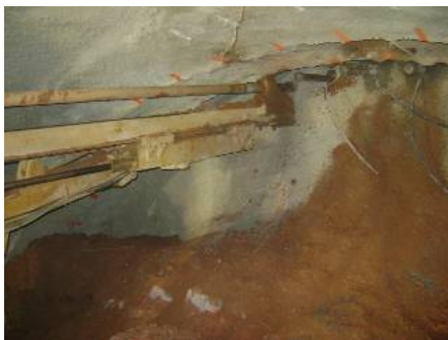
Figura 29 – Enfilagens injetadas
