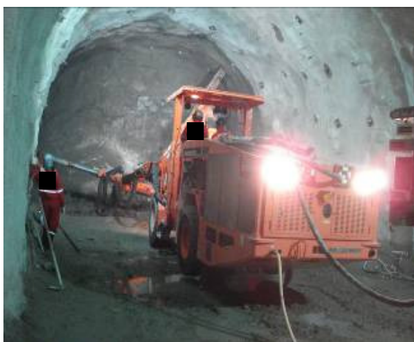
Figura 19 – Operação Jumbo/Perfuratriz (escavação em rocha)
