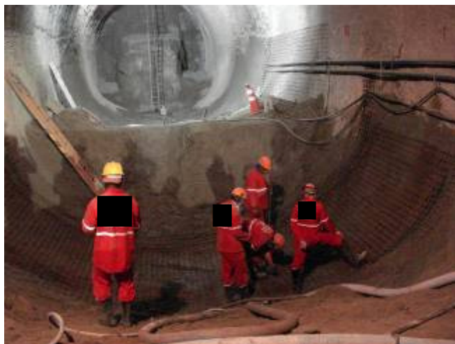
Figura 30– Concreto armado – arco invertido.
