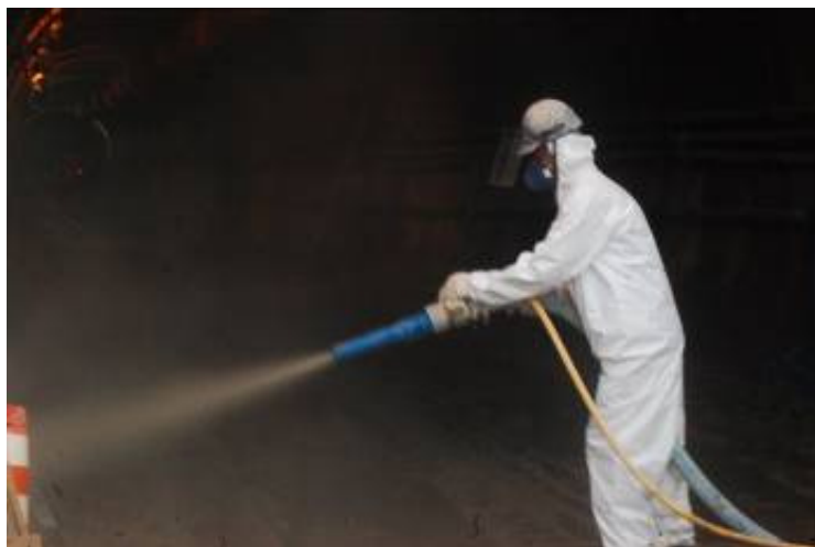
Figura 27 – Aplicação de concreto projetado
