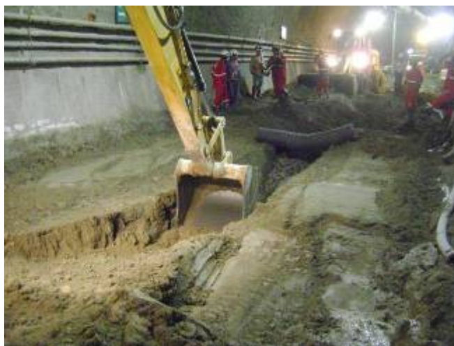
Figura 32 – abertura de valas e instalação de tubos de drenagem
