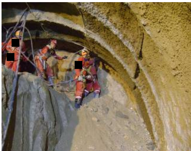
Figura 16 – Escavação manual (frio)
