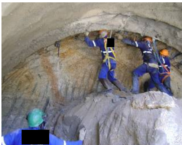
Figura 25 – Instalação de cambotas
