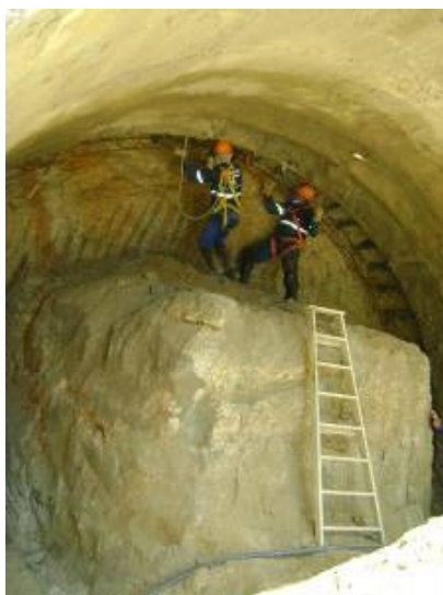
Figura 26 – Instalação de cambotas
