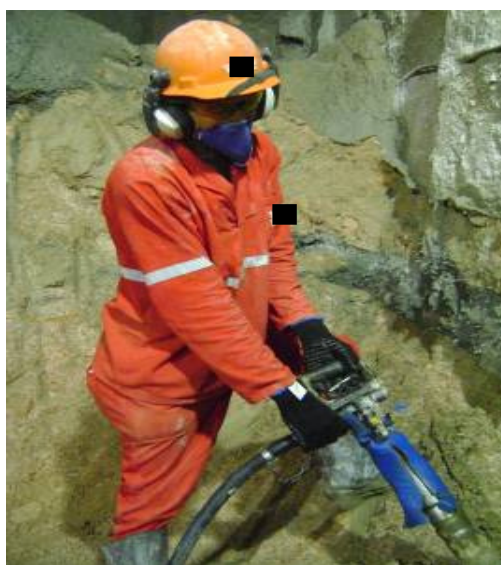
Figura 17 – Perfuração em rocha com martelo pneumático
