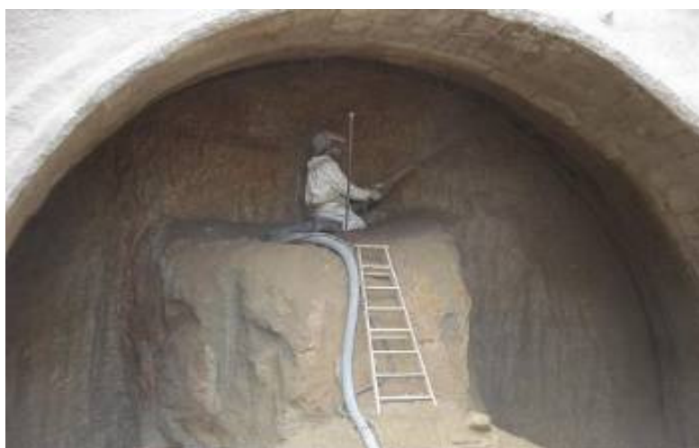
Figura 28 – Aplicação de concreto projetado
