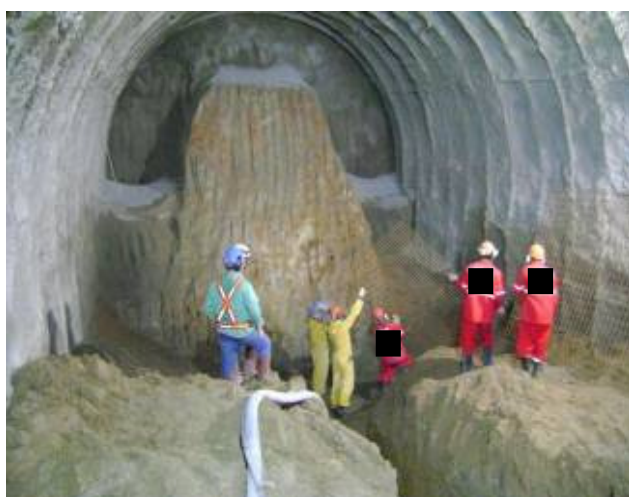
Figura 31 – Concreto armado – arco invertido.
