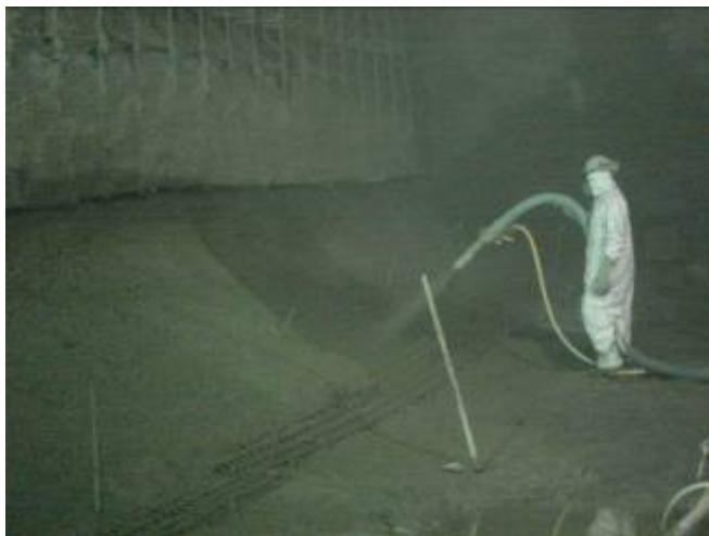
Figura 34 – acabamento no interior do túnel
