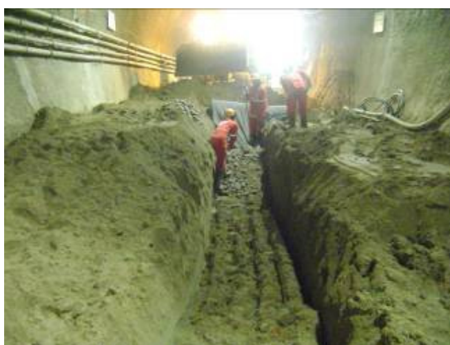
Figura 33 – abertura de valas e instalação de tubos de drenagem
