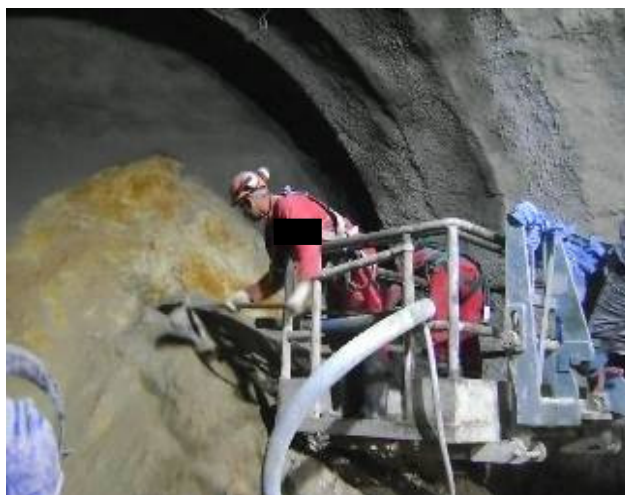
Figura 15 – Escavação manual (frio)
