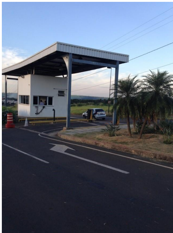
Figura 8 Portaria da FCA UNICAMP vista de frente. Foto por: Paolla Pazelli Rosolem, registrada em trabalho de campo realizado nos dias 21/04/2016 a 24/04/2016.
