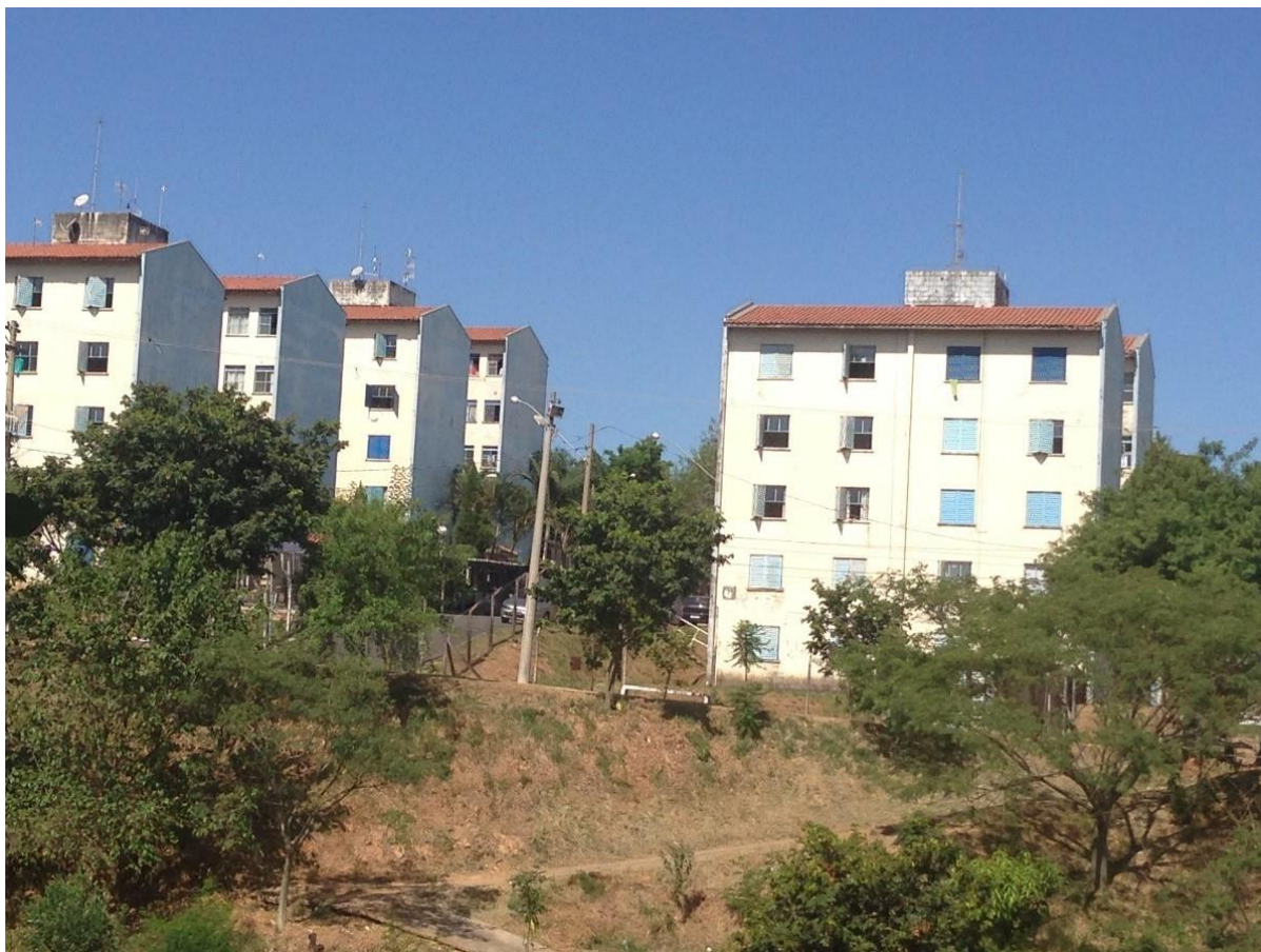
Figura 35 Conjunto Habitacional Olindo de Lucca - Localizado na periferia do município - Foto por: Paolla Pazelli Rosolem, tirada em trabalho de campo realizado nos dias 21/04/2016 a 24/04/2016
