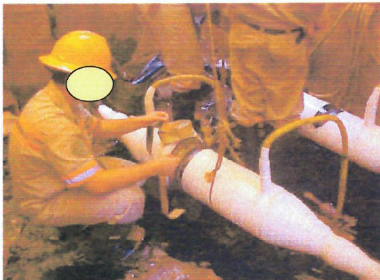
Fig. 12: Detalhe da montagem de uma emenda STOP* em cabo OF.
