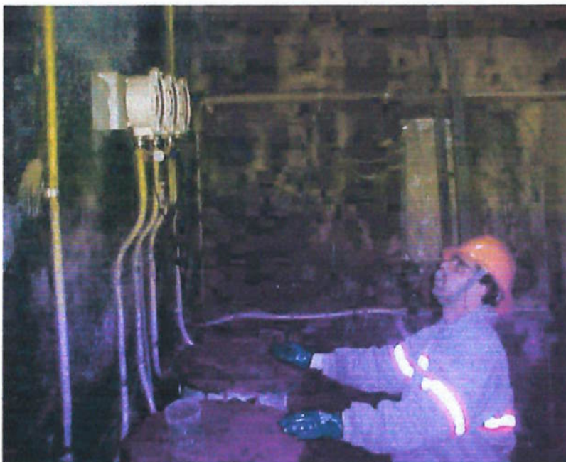
Figura 6: acesso a espaço confinado para leitura de manômetros
