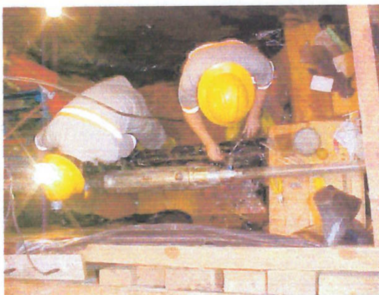
Fig. 12: Detalhe da montagem de uma emenda em cabo OF.
