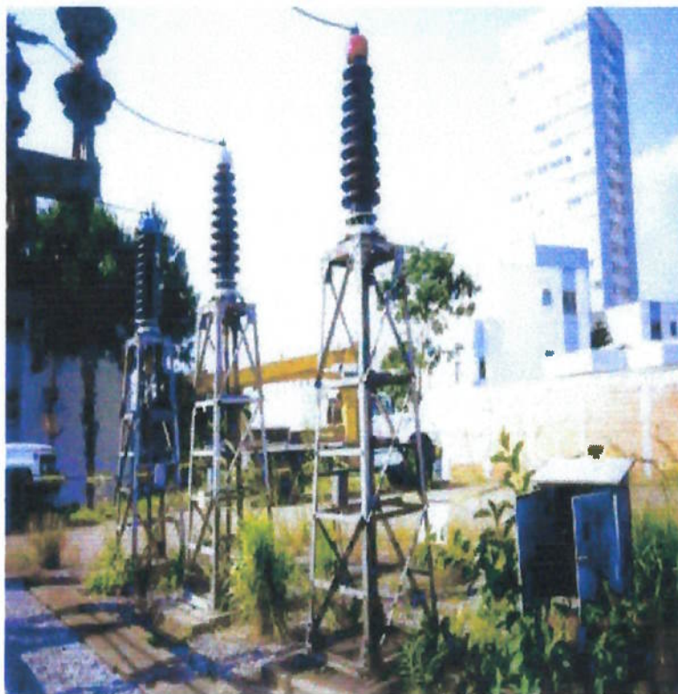
Figura 5: terminal ou mufla de terminação de linha subterrânea
