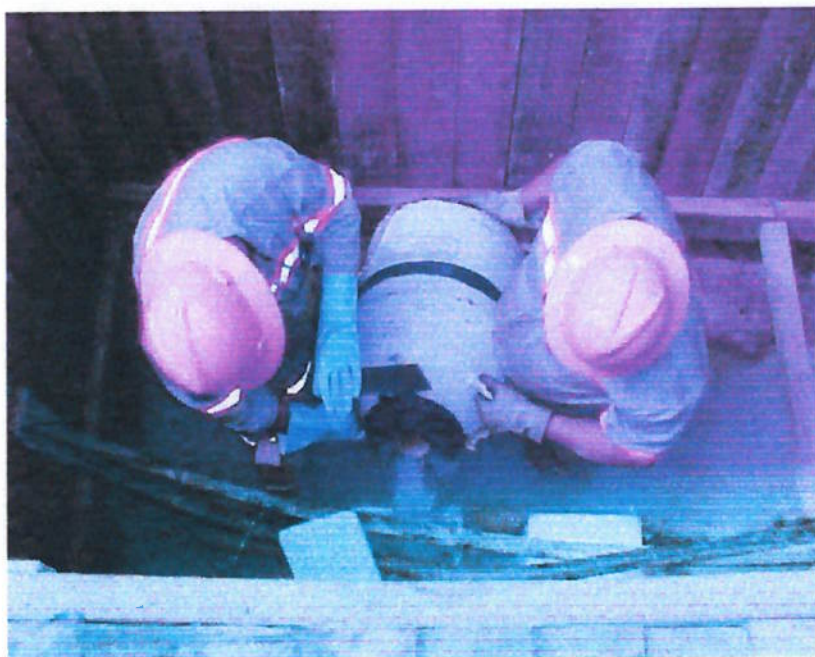
Figura 7: Trabalho com nitrogênio líquido sem uso do EPI adequado
