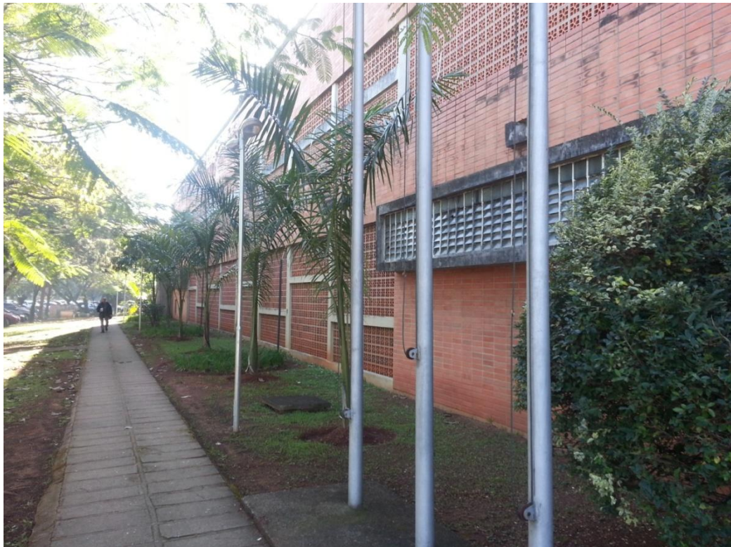
Figura 8 - Vista lateral do prédio
