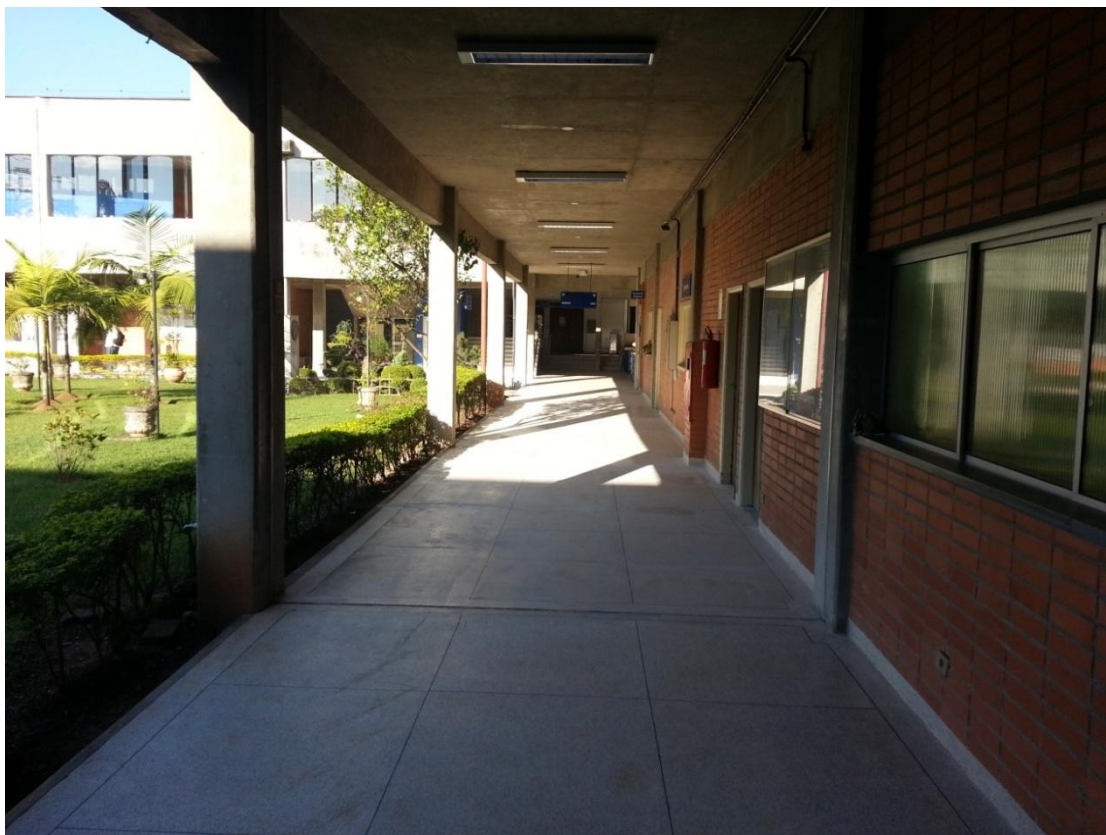
Figura 12 - Detalhe do primeiro andar e as amplas aberturas sem nenhum tipo de cobertura.
