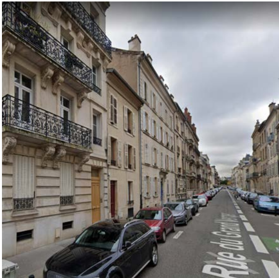
Figura 53: Edificações na zona UAa.
