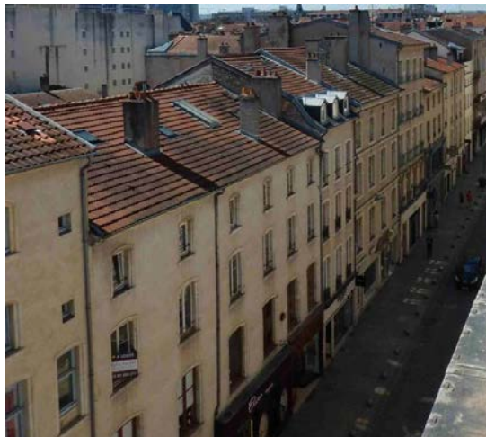
Figura 68: Estilo de telhado predominante.
