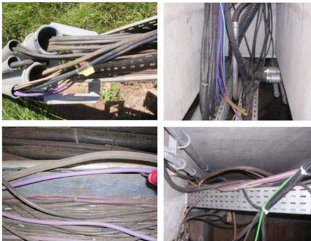
Figura 2-9 - Exemplo de cabos Profibus próximos a cabos de potência. [12]
