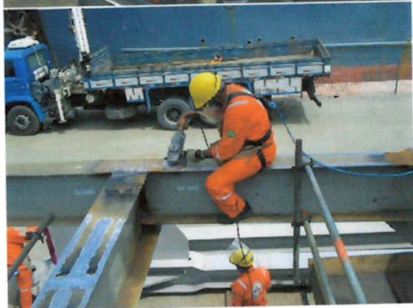
Foto 92 – Operação de limpeza da junta soldada através de esmerilhamento. Observar utilização de cinto de segurança com duplo talabarte para trabalho em altura.
