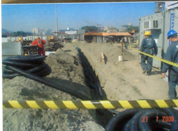
Foto 15 - Execução do envelope elétrico destinado à passagem dos cabos de alimentação elétrica das máquinas e equipamentos a serem utilizados durante a construção dos módulos de geração. (observar o isolamento da área).
