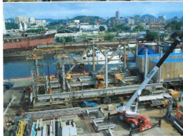
Foto 76 – Início da instalação dos geradores na estrutura do módulo A.
