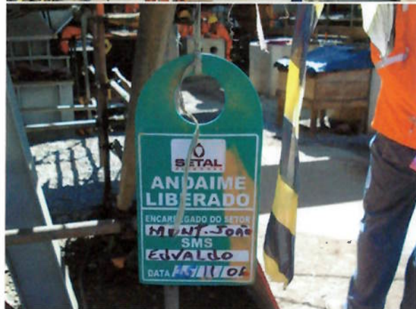
Foto 96 – Etiqueta de verificação e liberação da estrutura do andaime.
