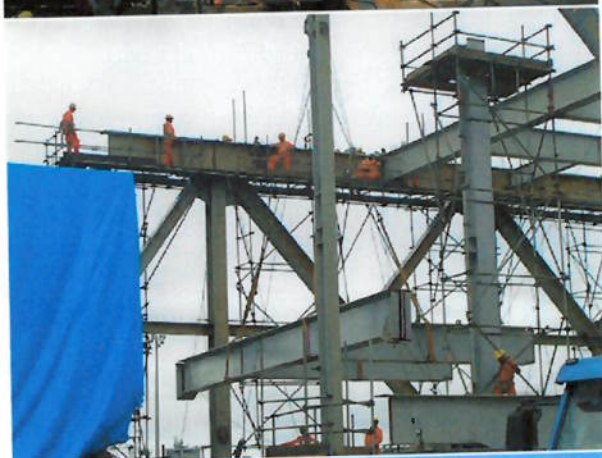
Foto 83 – Trabalho em altura, içamento de perfis estruturais e andaimes.
