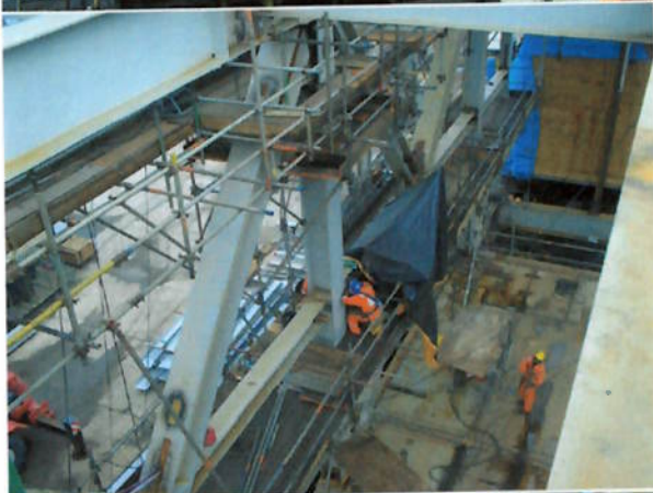
Foto 90 – Execução de Soldagem. Observar andaimes e acessos e necessidade de utilização de lona antichama.
