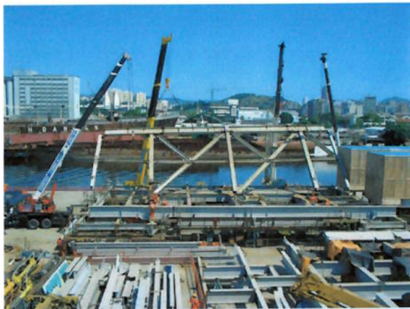
Fotos 73 e 74 – Montagem da estrutura metálica. Observar a movimentação das estruturas através de guindastes e andaimes para trabalho em altura.
