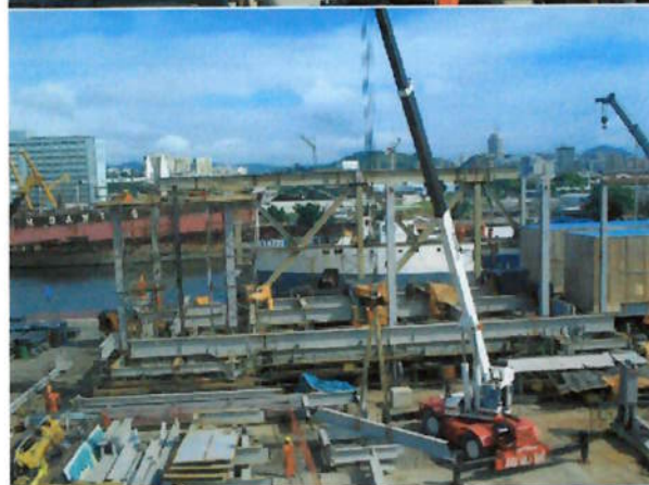
Foto 75 – Montagem da estrutura metálica. Observar que a área de montagem é restrita. Neste caso, o planejamento das atividades é fundamental para a segurança do trabalho.
