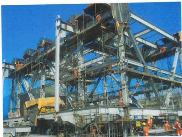
Foto 77 – Cabanas de material antichama montadas na estrutura superior destinadas a proteger as operações de soldagem dos efeitos do vento e demais intempéries que podem afetar a qualidade e a segurança da operação.
