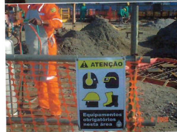
Foto 60 – Equipamentos de Proteção Coletiva (EPC): Placas de sinalização indicando a obrigatoriedade e quais são os Equipamentos de Proteção Individual (EPI) a serem usados para execução da atividade.
