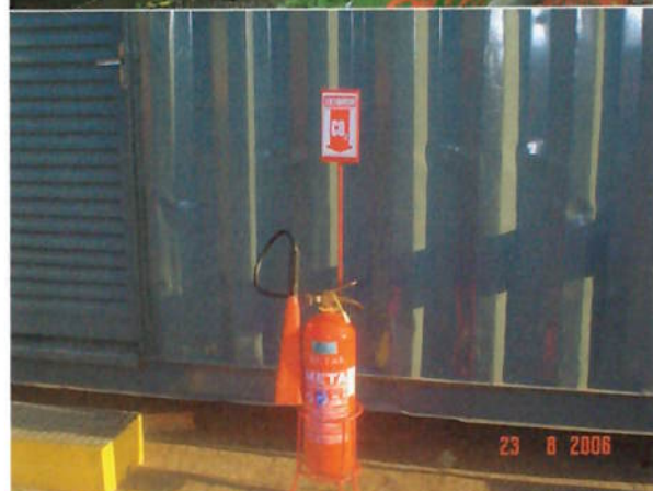
Foto 55 – Detalhe da identificação e instalação de extintor de incêndio no canteiro de obras.
