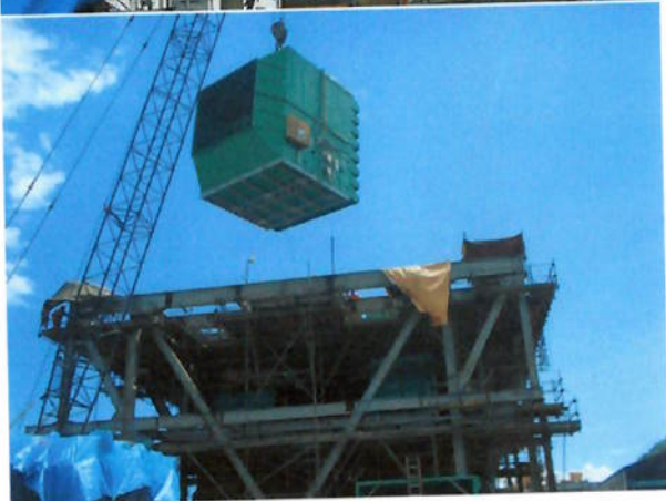
Foto 84 – Içamento de parte do sistema de exaustão de gases do gerador.
