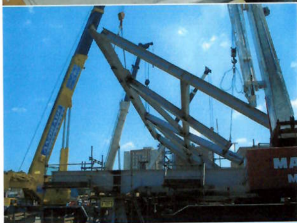
Fotos 71 e 72 – Içamento da estrutura lateral do módulo. As estruturas são montadas no solo e içadas através de guindastes. Observar que a soldagem realizada no solo minimiza o perigo envolvido no trabalho em altura bem como o risco de queda. Notar as estratégias de produção associadas aos aspectos de segurança do trabalho, resultantes do planejamento e análise preliminar dos perigos e riscos.
