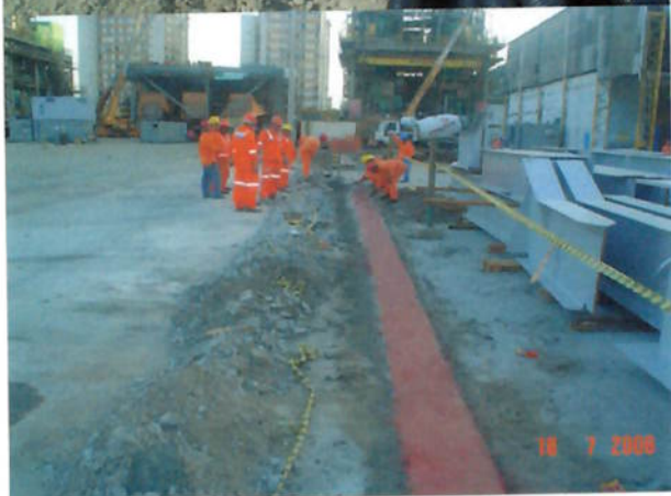
Foto 16 - Conclusão dos serviços de execução do envelope elétrico destinado à passagem dos cabos de alimentação elétrica das máquinas e equipamentos. (observar a identificação em tinta vermelha indicando existência de rede elétrica enterrada para o caso de escavação do local).
