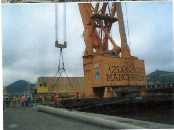
Foto 78 – Guindaste especial para içamento do container contendo um dos geradores. Cada Gerador pesa 185 toneladas.
