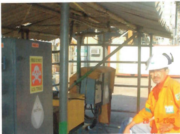
Foto 33 – Sinalização de segurança das instalações elétricas provisórias.
