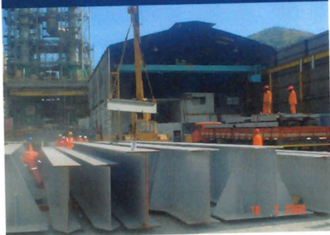
Foto 12 - Estruturas metálicas pré-fabricadas (vigas tipo "I") e operação de movimentação de cargas com guindaste.
