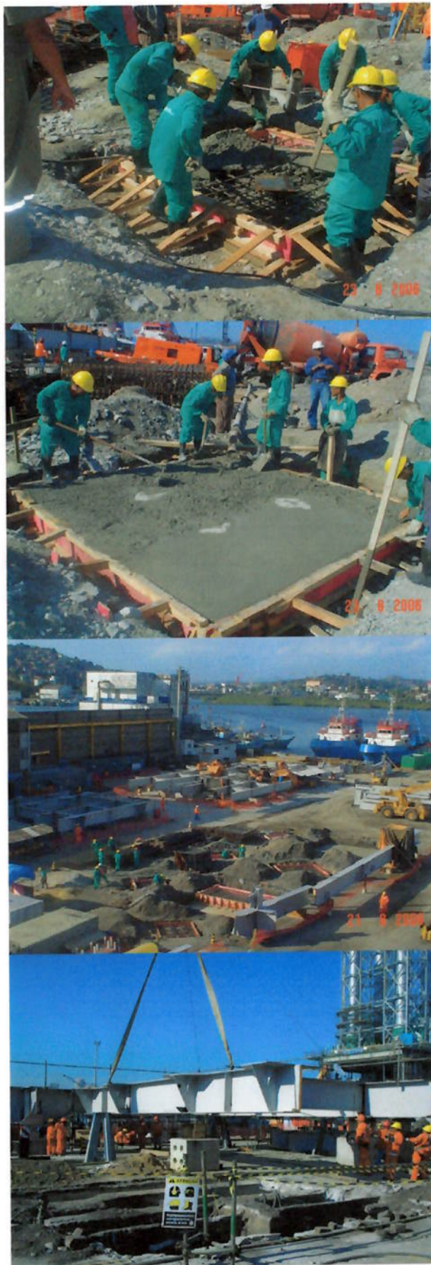
Fotos 37 a 40 – Concretagem das bases destinadas a suporta  o das estruturas dos M dulos de Gera  o A e B. Observar a utiliza  o dos equipamentos de prote  o individual (EPI) para atividades, envolvendo concreto armado. Observam-se ao redor da constru  o das bases, as atividades de pr -montagem das vigas estruturais dos m dulos. Observar a grande quantidade de movimentac  o de pe as e os perigos envolvidos, requerendo intensa atividade de treinamento, conscientiza  o e an lise de perigos e riscos.
