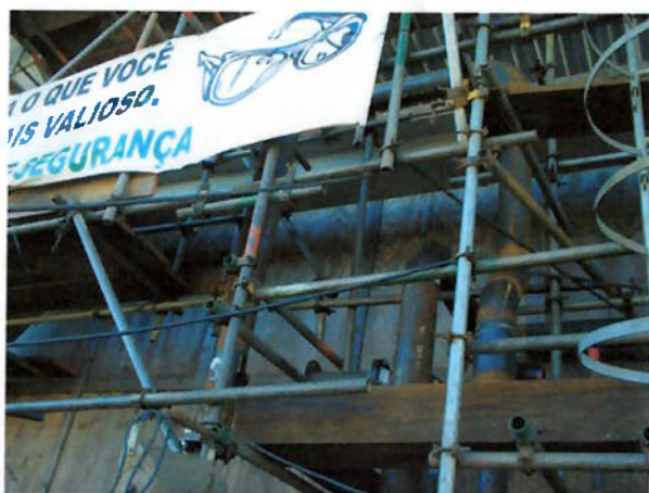
Foto 97 – Andaimes. Sistemas de fixação das estruturas tubulares e rodapés.
