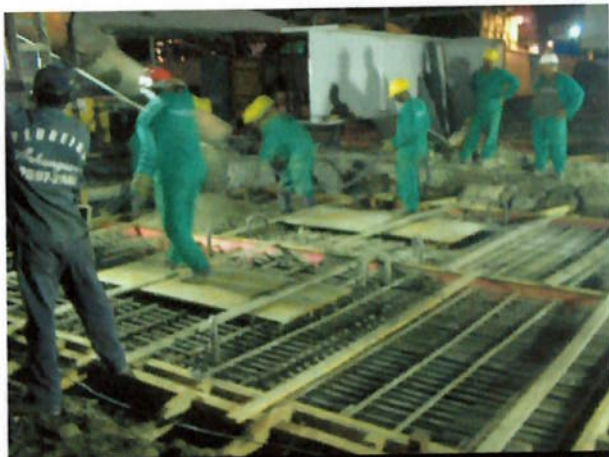
Foto 41 – Execução de concretagem durante o período noturno. Observar o nível de iluminamento requerido.
