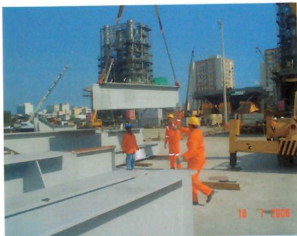
Foto 13 - Estruturas metálicas pré-fabricadas (vigas tipo "I") e operação de movimentação de cargas (observar o cabo direcionador da carga instalado no lado esquerdo da viga e os funcionários orientando a movimentação).
