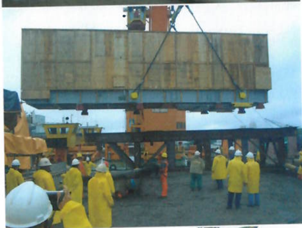
Fotos 79 e 80 – Içamento dos containers contendo os geradores.
