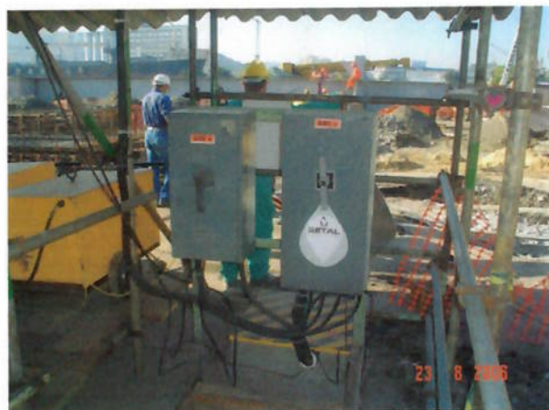
Foto 61 – Disposição adequada e sinalização das instalações elétricas provisórias.
