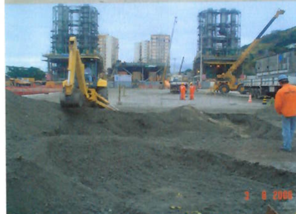
Fotos 34 a 36 – Escavação para início da construção das fundações e bases de concreto destinadas a suportarem as estruturas dos Módulos de Geração A e B
