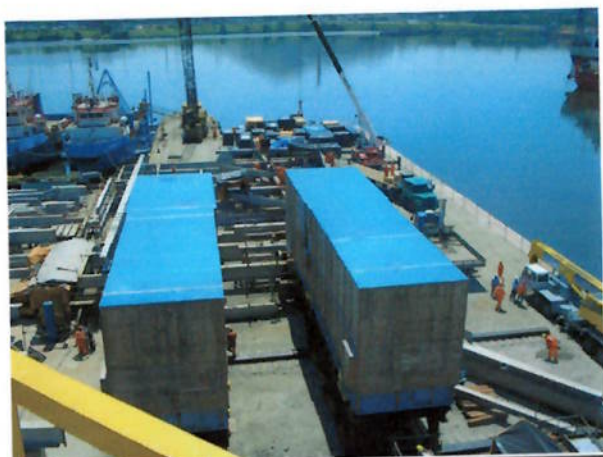
Foto 81 – Geradores acomodados na estrutura do módulo.
