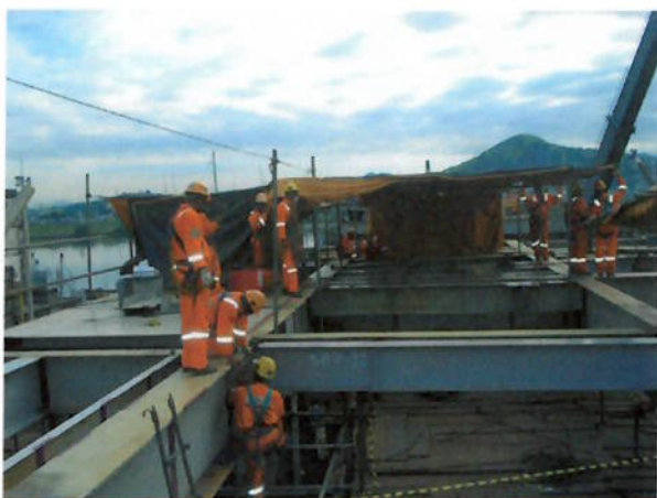
Foto 93 – Montagem de estruturas. Observar andaimes e "cabanas" para soldagem ao fundo.
