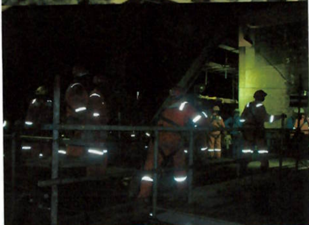
Foto 42 – Execução de concretagem durante o período noturno. Observar a sinalização através de faixas reflexivas no uniforme dos trabalhadores.
