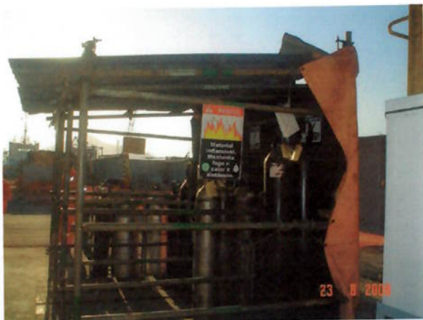
Foto 57 – Detalhe da instalação dos cilindros de oxigênio e acetileno local ventilado, coberto, protegido contra raios solares, umidade, choques mecânicos e identificado, através de placa de sinalização quanto ao risco de incêndio.
