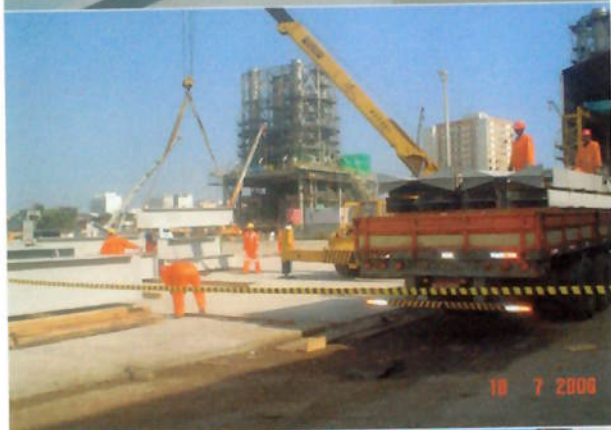
Foto 14 - Estruturas metálicas pré-fabricadas (vigas tipo "I") e operação de movimentação de cargas (observar o isolamento da área com fita "zebrada").
