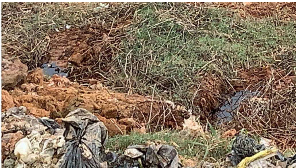
Foto 15 - Escoamento de lixiviados nos taludes do maciço de resíduos – situação em 2021
