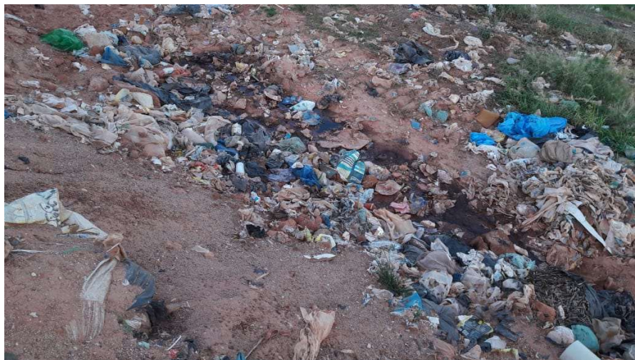
Foto 13 - Afloramento de lixiviado nos taludes do maciço (01/10/2019)
