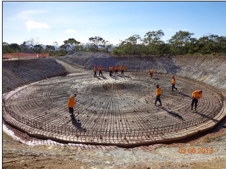
Figura 7 – Preparação da fundação
