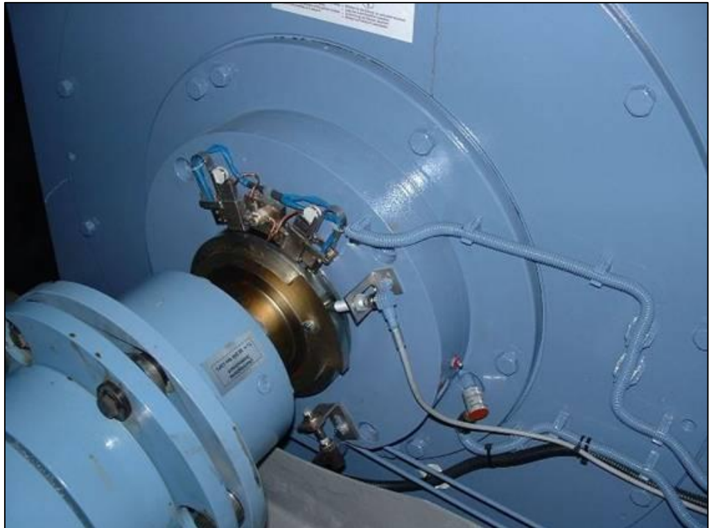
Figura 16 - sensor de rotação de uma turbina eólica
