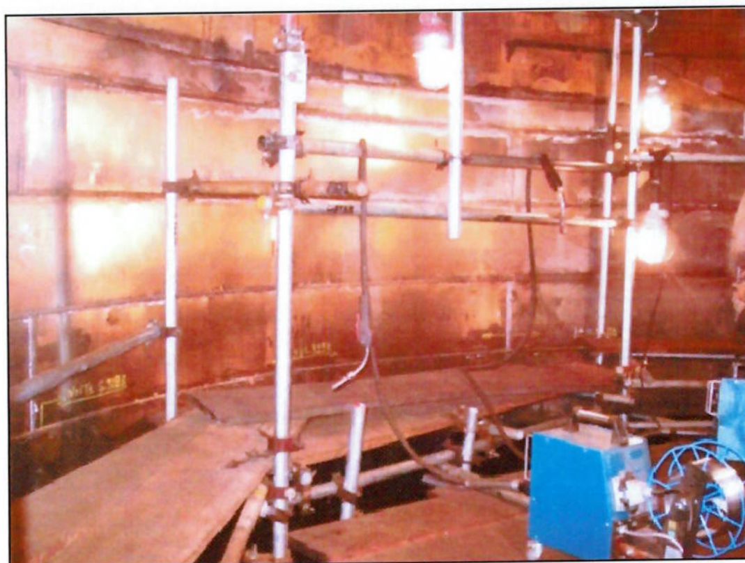
Figura 2.19 – Instalação de lining sem sobreposição em torre de destilação à vácuo. Chapas em AISI 317L com dimensões 400 X 3000 mm.
