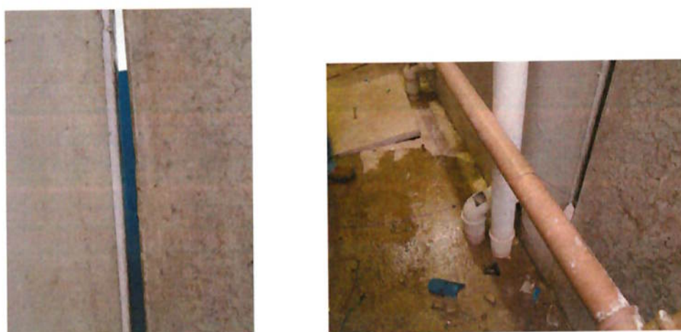
Foto 27 – Espaçamento entre peças pré-moldadas.
