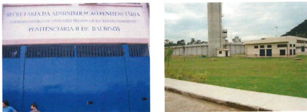
Foto 6 - Entrada da Penitenciária de Balbinos e Vista Geral do CDP de Caraguatatuba
