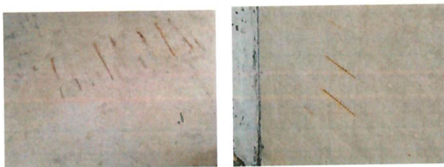
Foto 21 – Armadura positiva da laje da torre de vigia (direita) e na parede da linha de tiro (direita)
