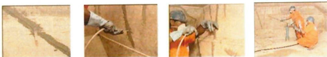
Foto 41 – Exemplo de recuperação de trincas com uso de epóxi (créditos: José Silva Lapa)
