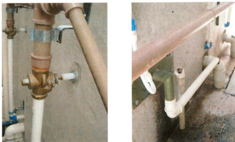
Foto 40 – Pino plástico para acionamento da válvula em Caraguatatuba (esquerda) . e solução de terminal metálico em Balbinos (direita).
