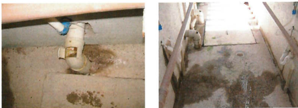
Foto 31 – Corte na tubulação de esgoto (esquerda) e caixa de passagem de esgoto na galeria técnica (direita).
