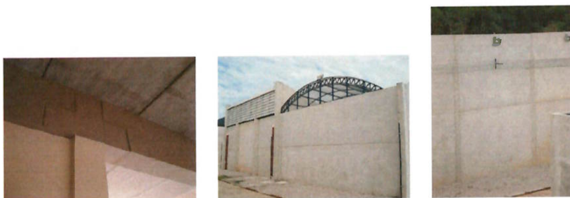
Foto 24 – Estrutura da penitenciária em pré-moldado.
