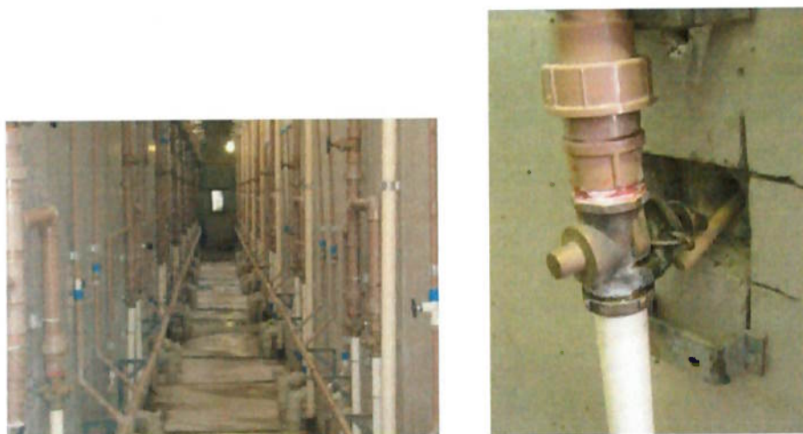
Foto 30 – Galeria técnica (esquerda) e pino de madeira para acionamento da válvula (direita).
