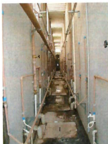
Foto 18 - Vista geral da galeria técnica
