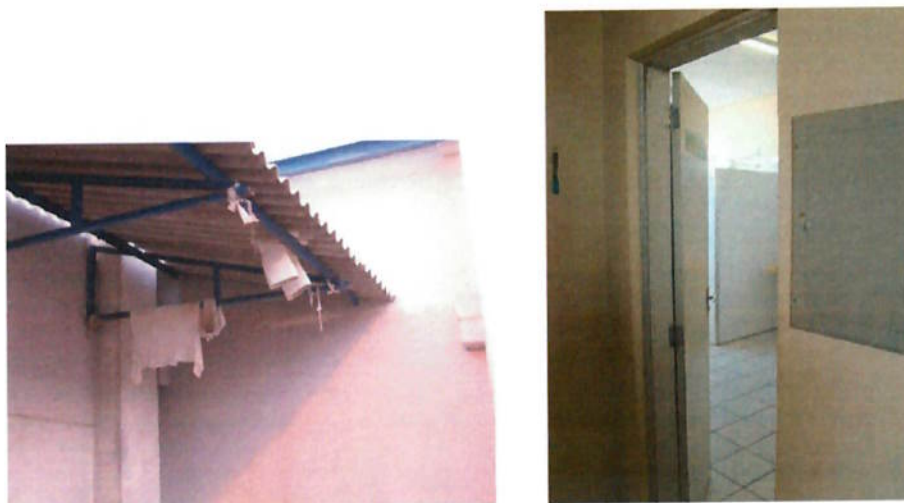
Foto 37 – Cobertura da região de carga/descarga da cozinha (esquerda) e porta do banheiro do corpo da guarda (direita).
