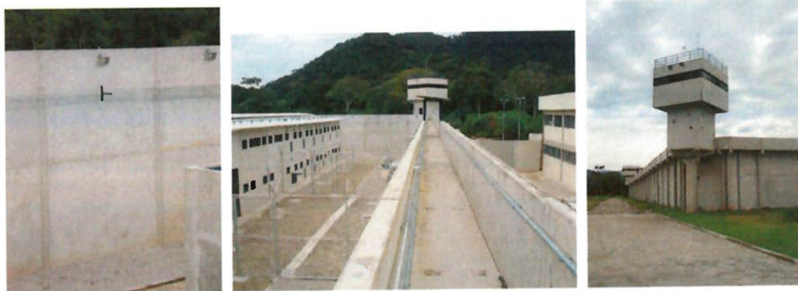
Foto 10 - Muralha, passeio da muralha e torre
