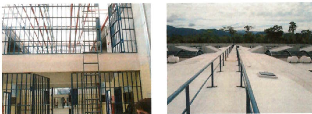
Foto 19 - Gaiola 1 e rota de fuga na cobertura
