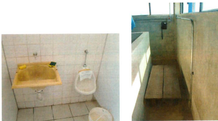
Foto 38 – Tanque no banheiro do corpo da guarda (esquerda) e janelas das torres (direita).
