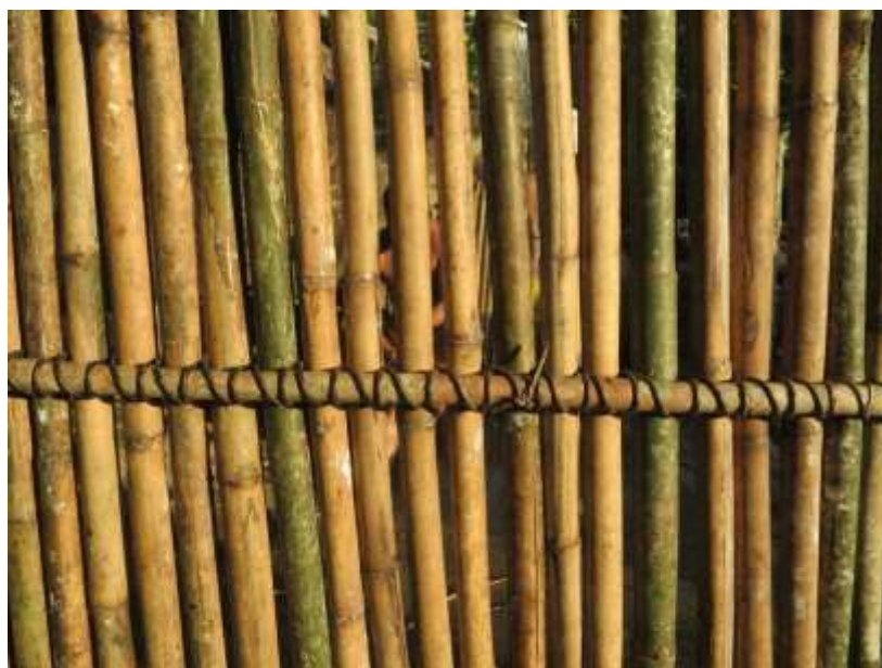
Figura 19 - Trecho da parede de bambu e cipó construída no mutirão. Fonte: Karina Ferro, fevereiro de 2016.
