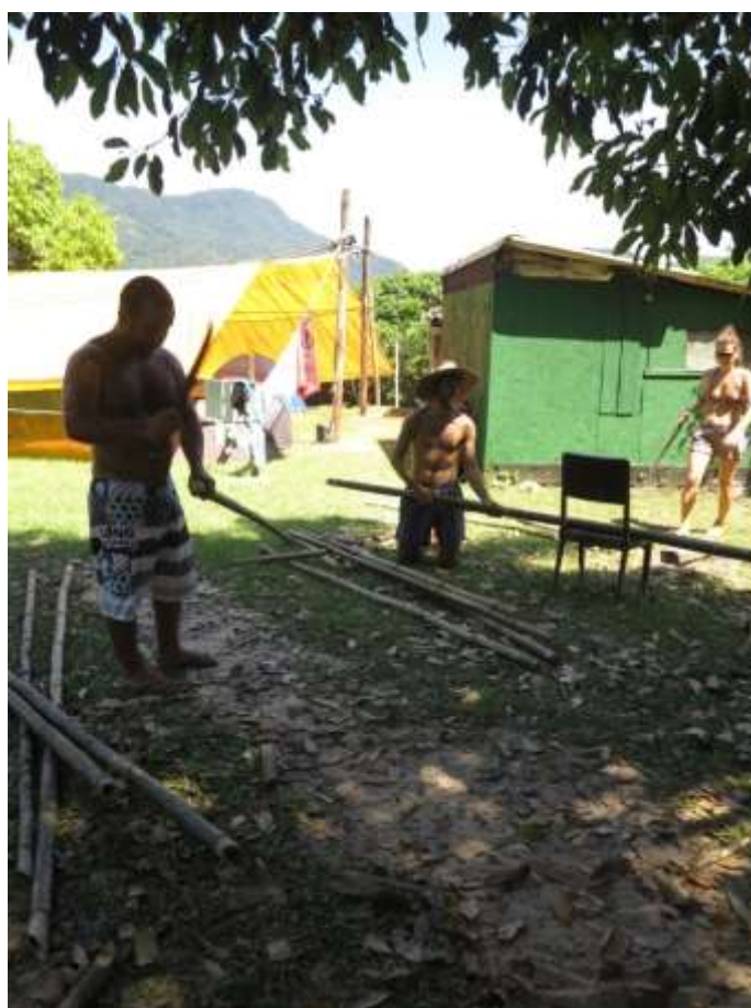
Figura 18 - Corte e preparo do bambu para construção de parede. Fonte: Karina Ferro, fevereiro de 2016.
