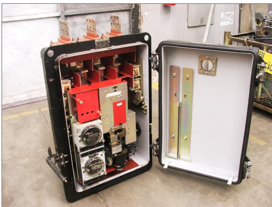
Figura 16: Protetor de redes modelo CM-22, relé eletromecânico (AES Eletropaulo, Corp.)
