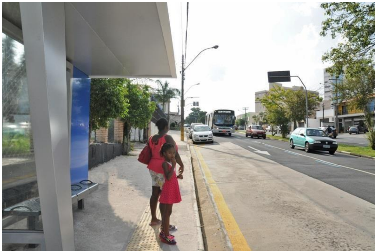
Figura 15. Foto de novo abrigo de ônibus em Piracicaba/SP. Fonte: SEMUTTRAN, 2019.
