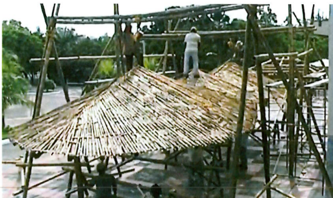
Figura 3.7 – Montagem dos stands. Fonte: www.arquiteturamixta.com
