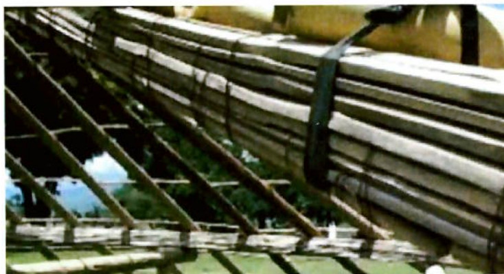
Figura 5.1 – Vigas conjuntas com amarres.
