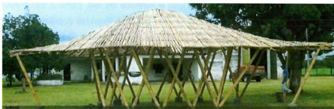
Figura 1.4 – Primeiro protótipo desenvolvido na M.A. com dupla curvatura.
