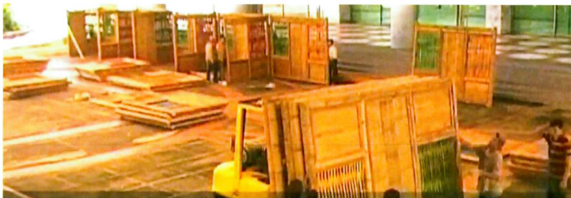
Figura 3.6 – Montagem dos stands. Fonte: www.arquiteturamixta.com
