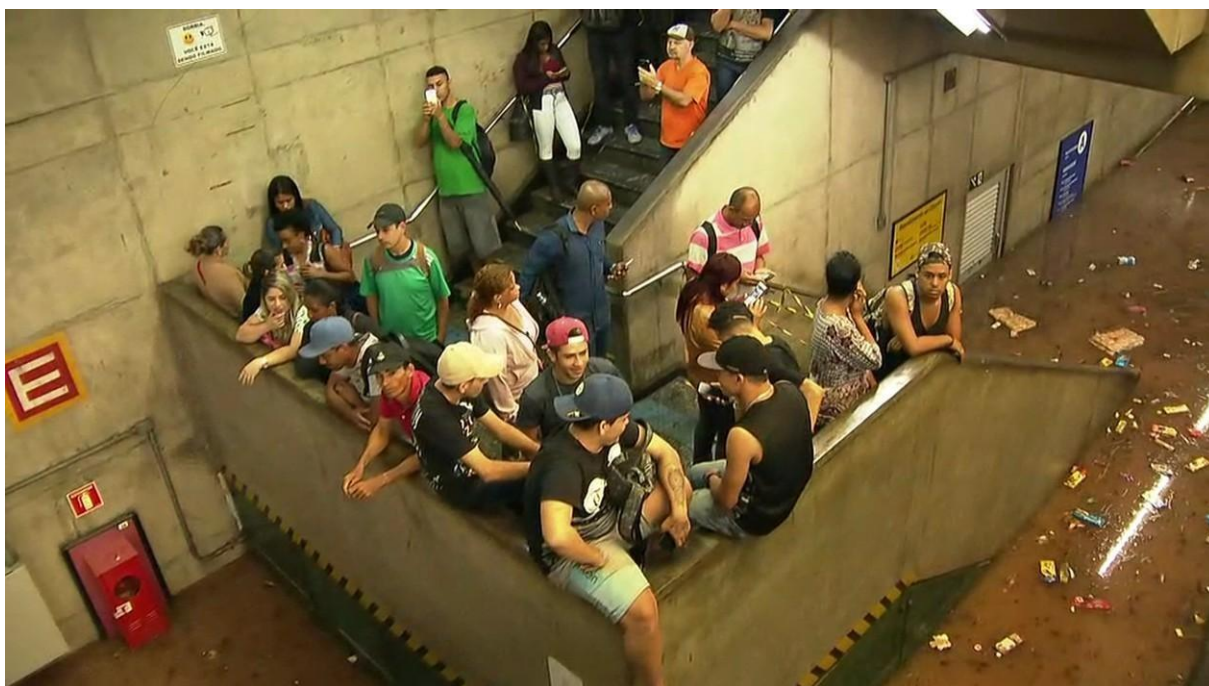
Figura 37: Níveis subterrâneos da estação Santo André são invadidos por alagamentos (2016)
