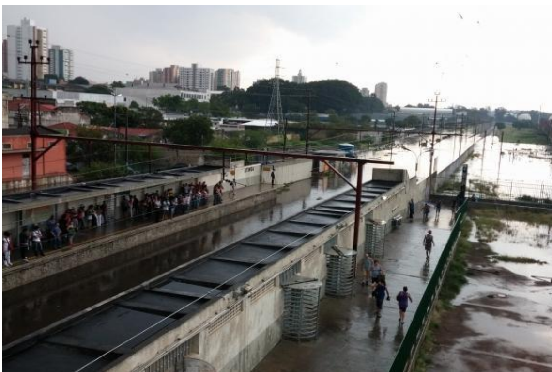
Figura 8: Circulação de trens interrompida na linha 10 por trecho alagado na altura de Utinga
