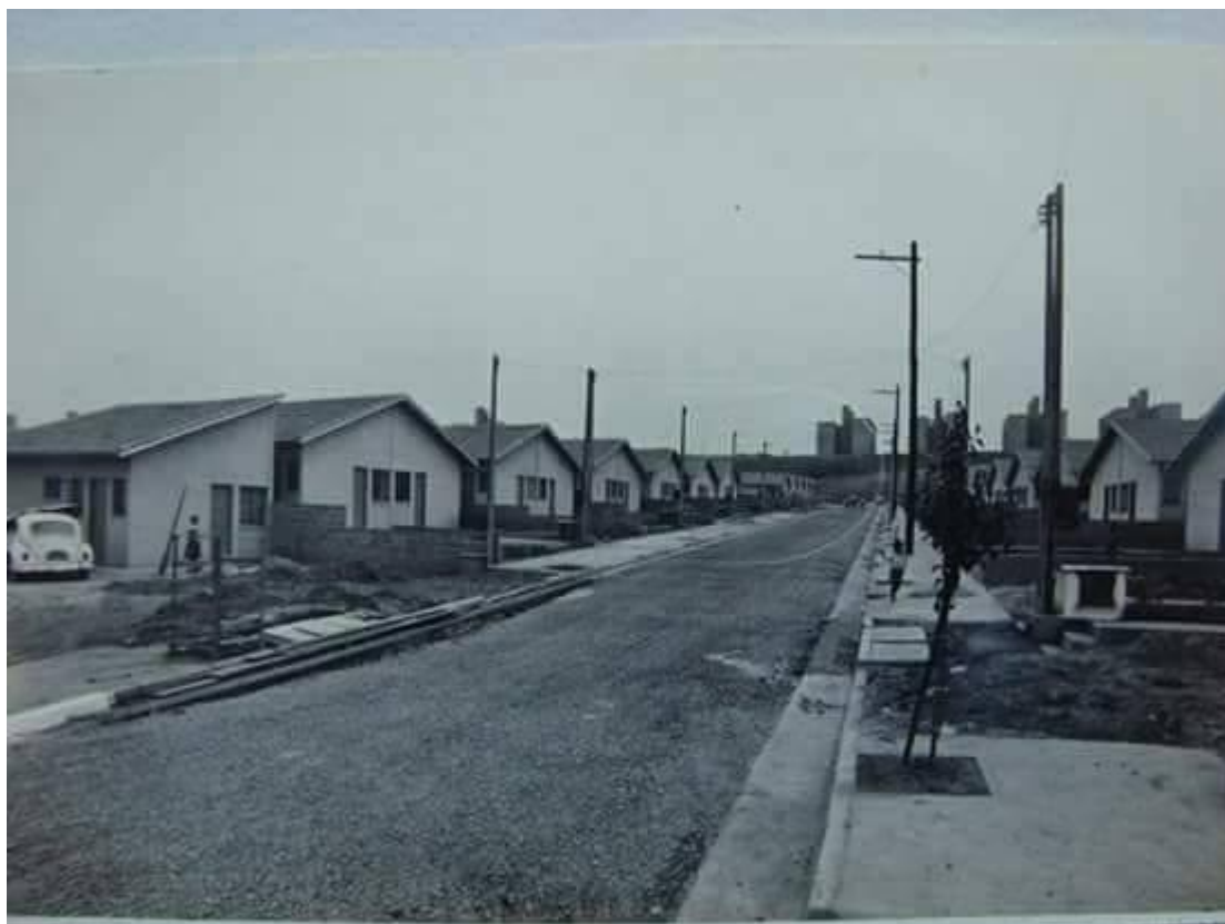
[Figura 10: rua de casas térreas recém construídas em Itaquera I, 1977-78]
