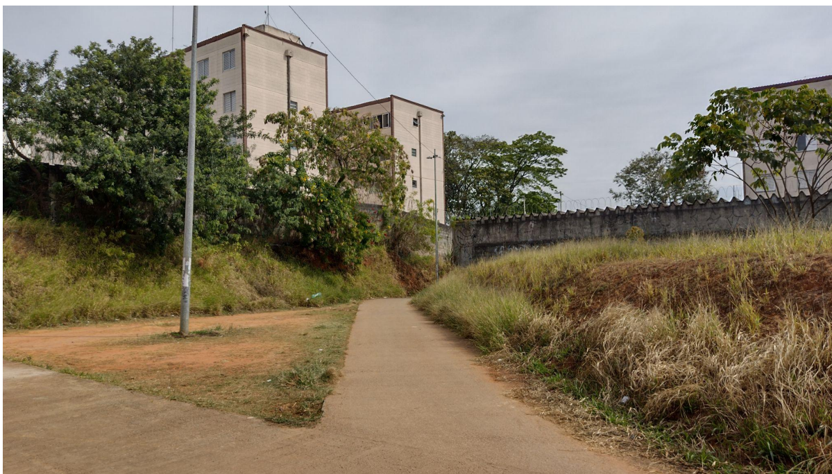
[Figura 55: Aspecto da entrada ao conjunto proporcionada pela passarela nova, 2022.]
