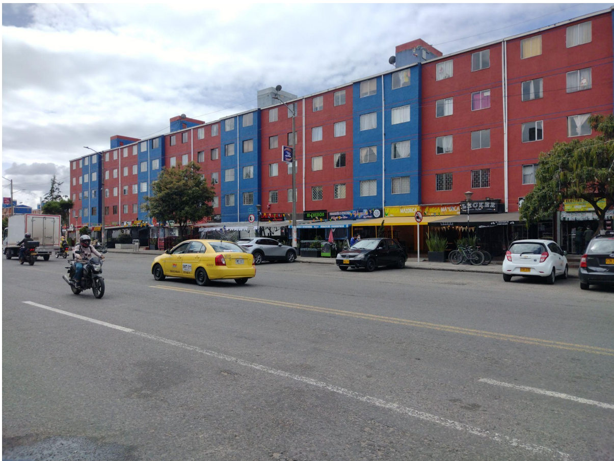
[Figura 67: Bares e restaurantes nos térreos de edifícios residenciais avançam sobre as calçadas e reconfiguram a relação com o espaço público em Ciudad Kennedy, 2021.]
