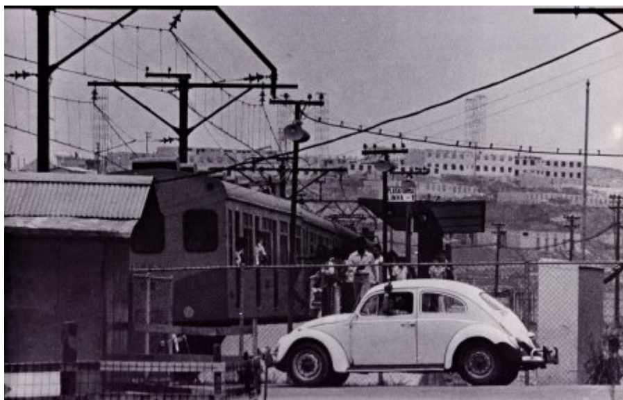
[Figura 39: antiga parada de trem de Artur Alvim, com a COHAB Itaquera I em construção ao fundo,
