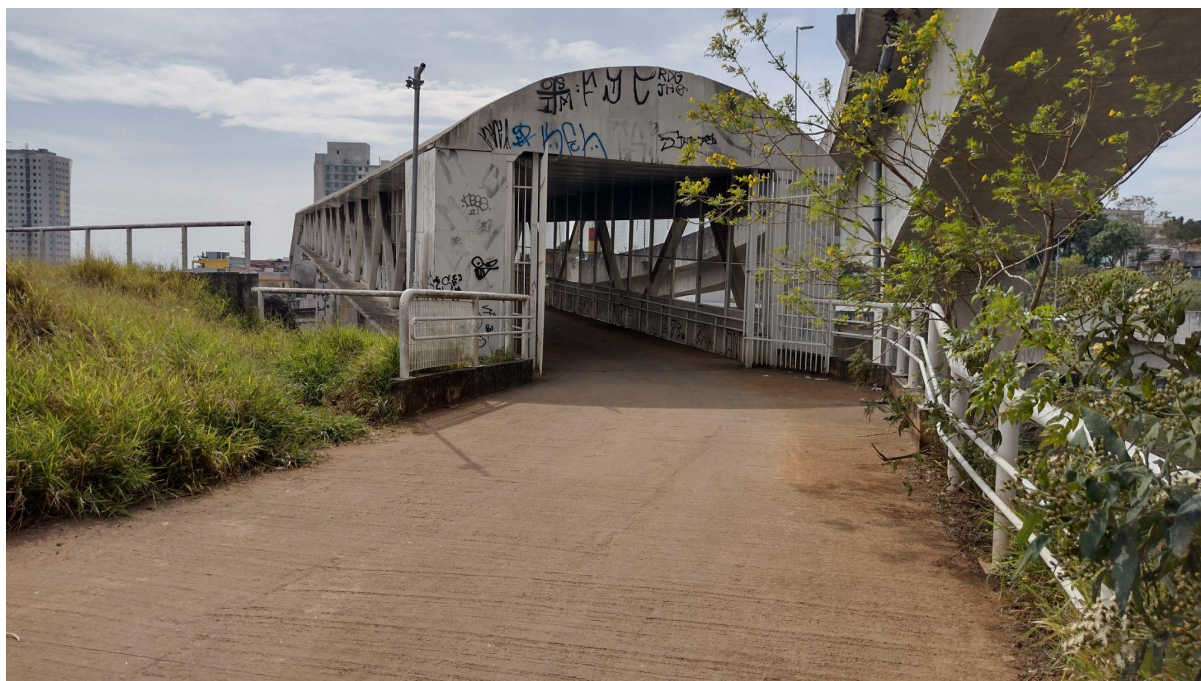
[Figura 54: Foto da passarela nova de acesso ao conjunto Itaquera I, 2022.]
