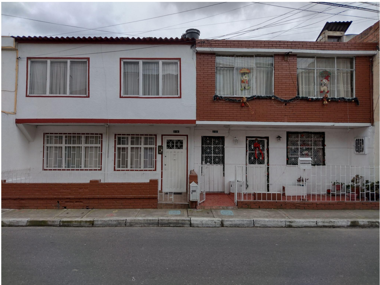
[Figura 56: Foto das fachadas de duas casas vizinhas parcialmente alteradas em Ciudad Kennedy, 2021.]
