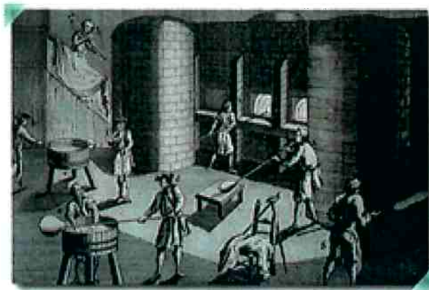
Figura 2-7 Ilustração do processo medieval de produção de vasilhames pelo método de sopro
