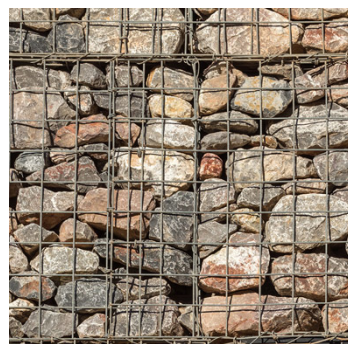
Muro gabião com pedras naturais para contenção da topografia.
