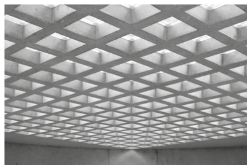
[fig. 23] Laje nervurada de concreto armado. Referência: Yale Center for British Art - Louis Kahn, New Haven (EUA), 1974.
