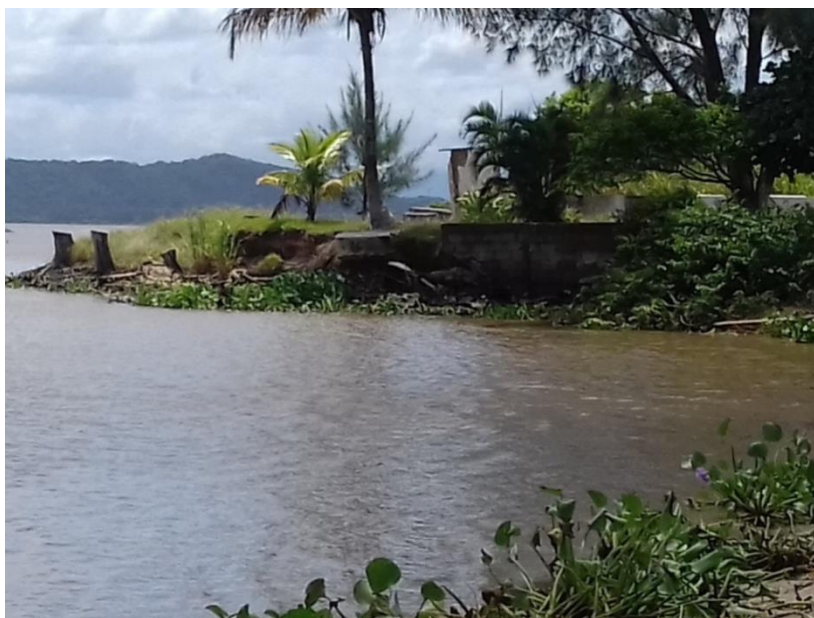
Figura 31 - Foto de construção sendo erodida ao longo das barrancas do Mar Pequeno. Autor: Alba, 2016
