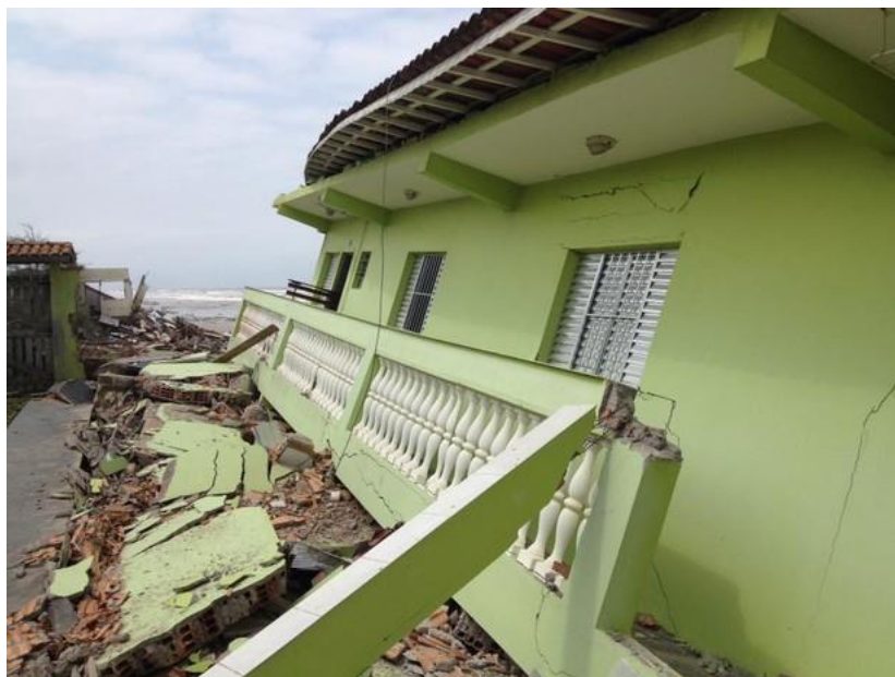
Piso da pousada ficou destruído e paredes estão rachadas (Foto: Ricardo Luiz/Arquivo Pessoal)
