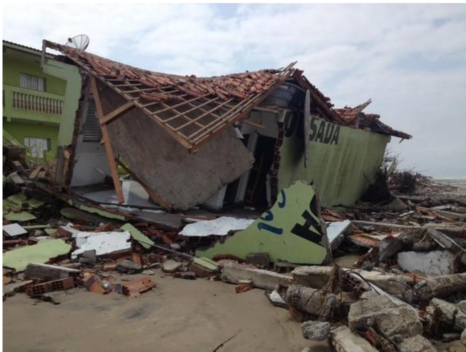
Paredes e pilastras não aguentaram a ressaca (Foto: Ricardo Luiz/Arquivo Pessoal)
