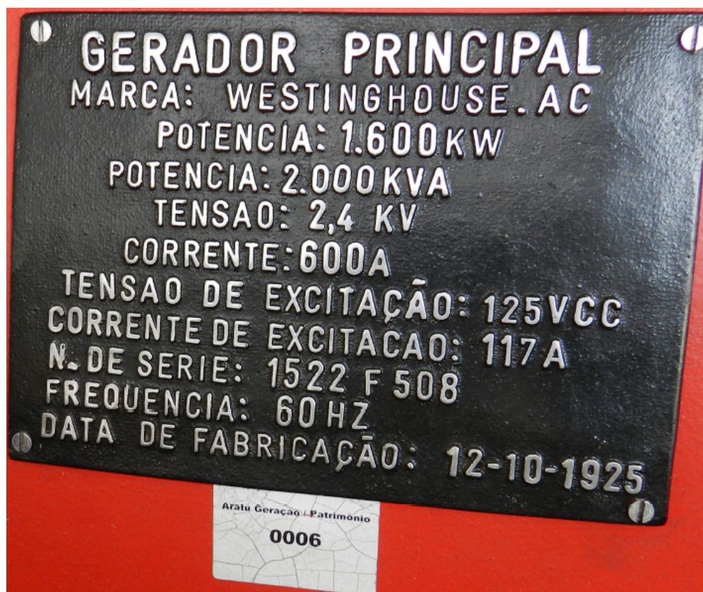
Figura 8 – Placa de dados técnicos do gerador da CGH. Fonte: (PAULA, 2020).
