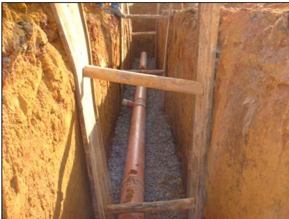
Figura 19 – Uso indevido de escoramento Fonte: Acervo pessoal do autor
