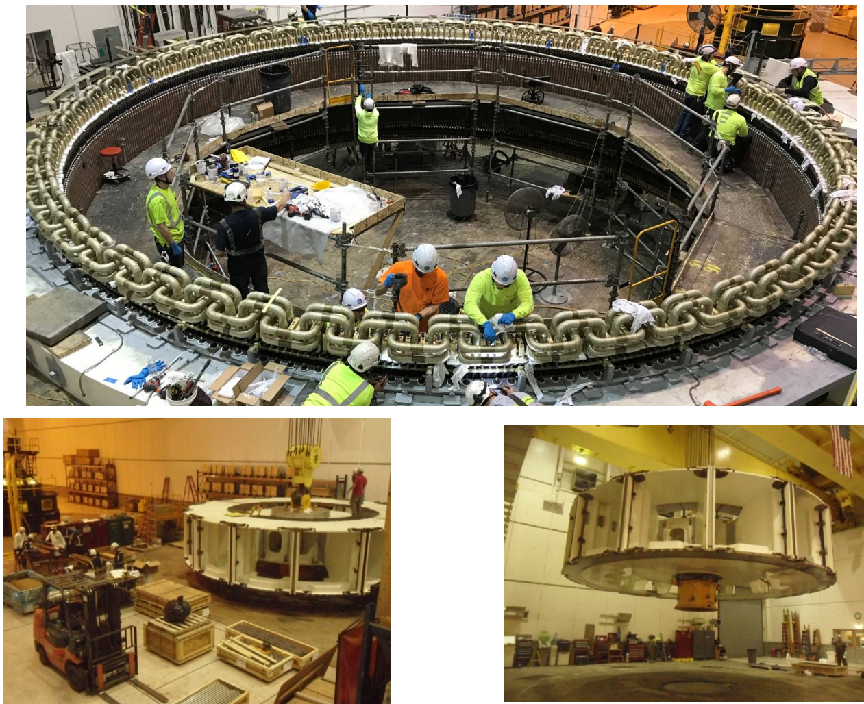
Figura 7.1.3 – Processo de repotenciação do gerador de Wanapum
