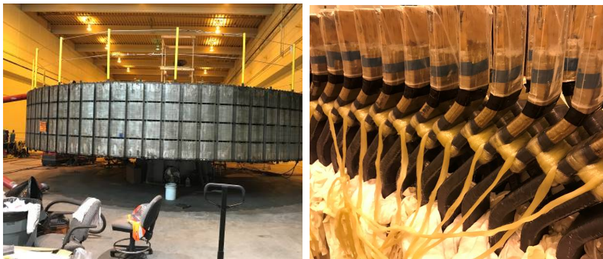
Figura 7.2.4 – Processo de repotenciação do gerador de Priest Rapids
