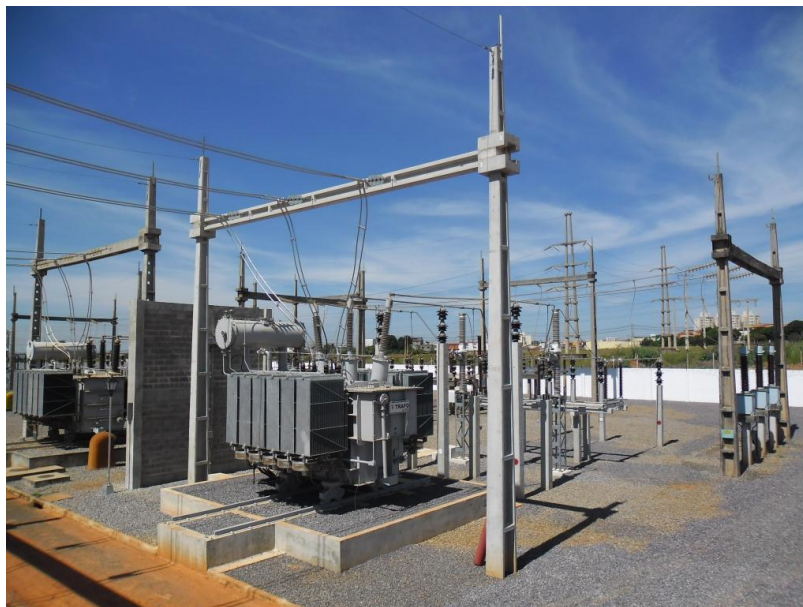
Figura 15 – Subestação com parede corta-fogo FONTE: Proelt Engenharia Elétrica
