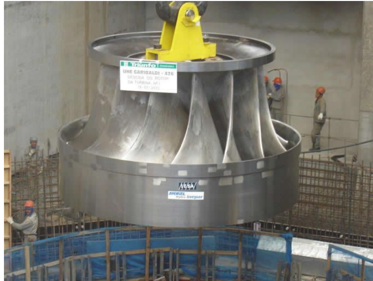
Figura 4 – Descida de Rotor Francis FONTE: Inepar
