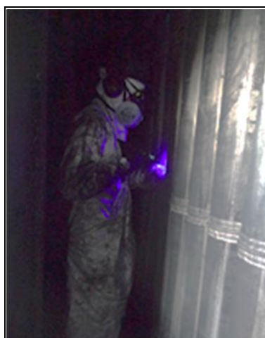
Figura 28 – Inspeção de Mangas.
