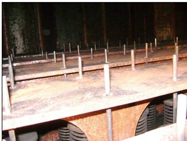
Figura 24 – Ganchos e Molas de Fixação das Mangas.
