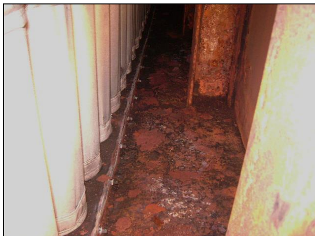
Figura 25 – Fixação das Mangas no Piso.
