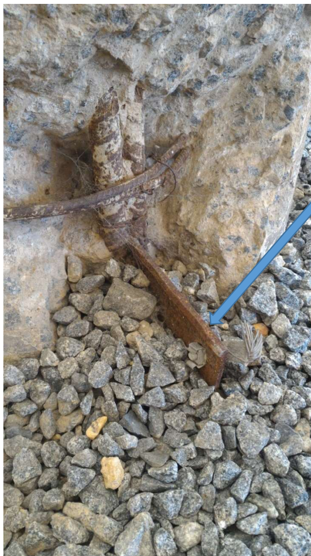
Figura 09 – Inseto metálico na parte inferior da ferragem estrutura
