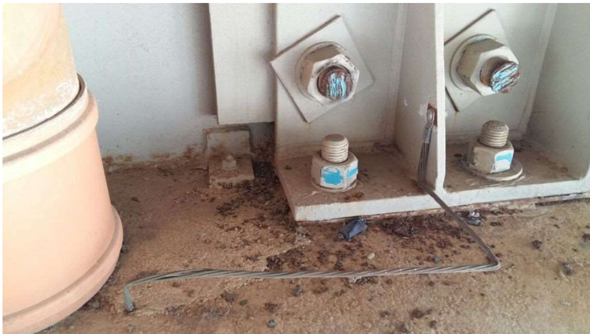
Figura 12 – Conexão da estrutura da cobertura a ferragem estrutural de pilar, típico 1
