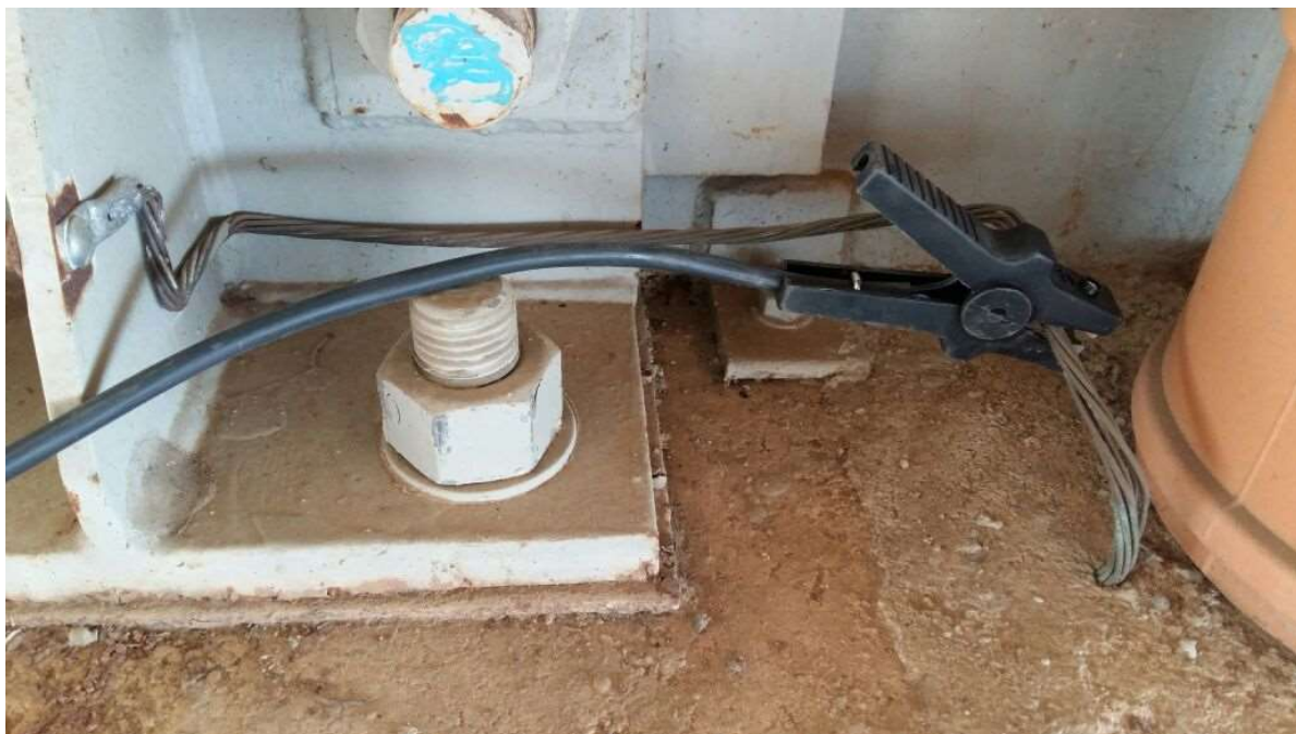
Figura 13 – Conexão da estrutura da cobertura a ferragem estrutural do pilar, típico 2
