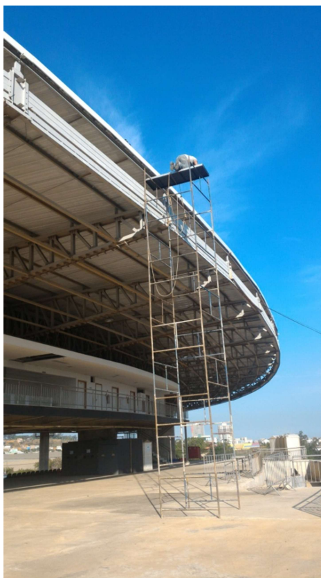
Figura 10 – Acesso a cobertura metálica para inspeção e medição
