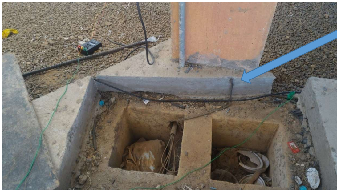
Figura 07 – Ponto de acesso ao anel de aterramento para quadro de energia
