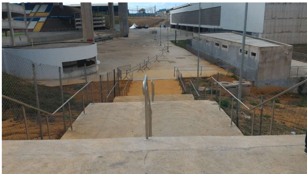
Figura 31 – Instalações metálicas tipo guarda corpo
